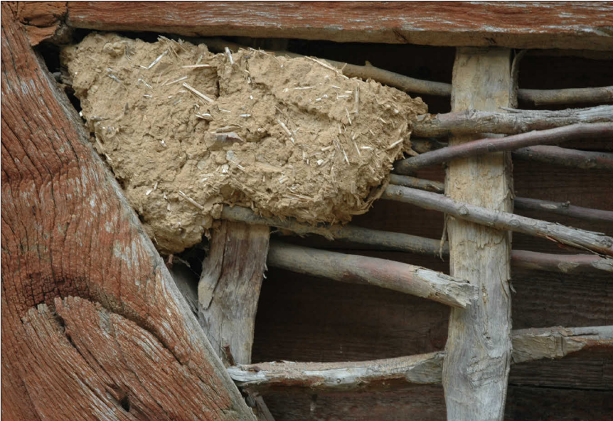
Abbildung 3: Löss und Lösslehm wurden gemischt mit Stroh zum Füllen der Flechtwände von Fachwerkhäusern; Foto: A. Stahr.
