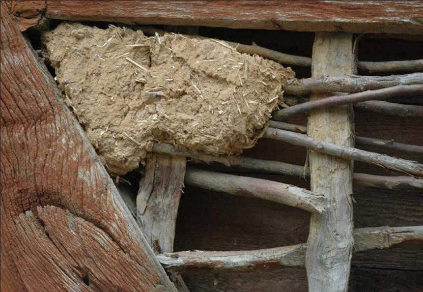
Abbildung 3: Löss und Lösslehm wurden gemischt mit Stroh zum Füllen der Flechtwände von Fachwerkhäusern; Foto: A. Stahr.
