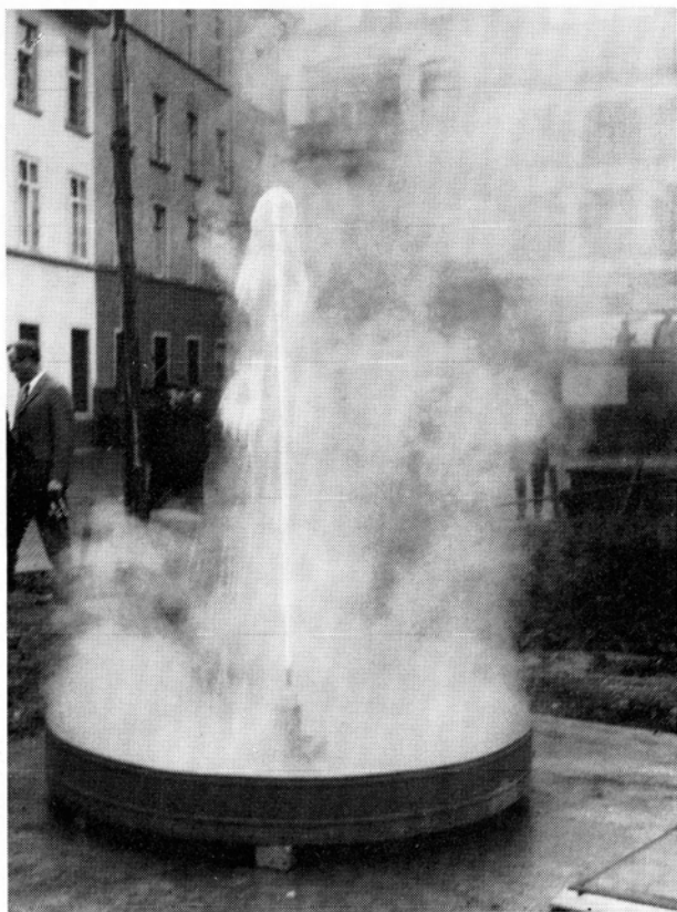
Abb. 7. Bohrung 1 am Kochbrunnen; Springerversuch am 6. April 1966. phot. F. MICHELS.
