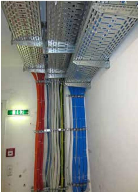
Ca. 1.500 m Kabel mussten für die neue EDV-, Server- und Technikzentrale verlegt werden.
