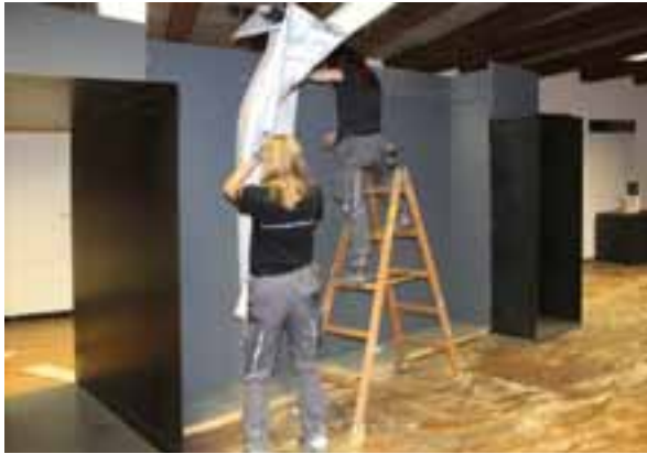
Im Zuge der Vorarbeiten für die Neuaufstellung der Dauerausstellung des Zeughauses wurden die Einbauten der alten Präsentation von der Museumswerkstatt abgebaut. Foto: TLM
