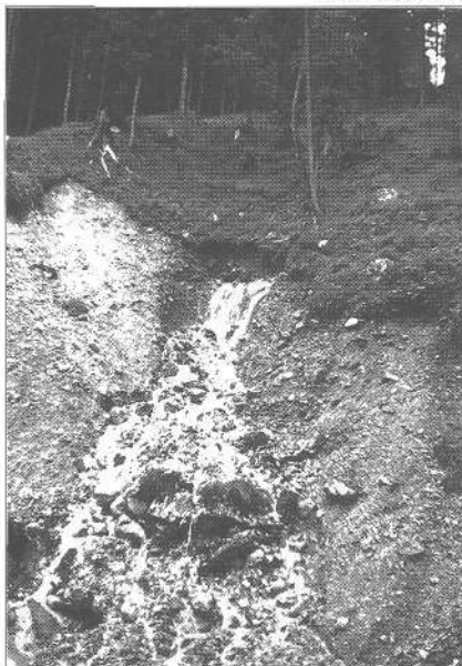
Abb. 13. Hangabriß mit Wasseraustritt.
