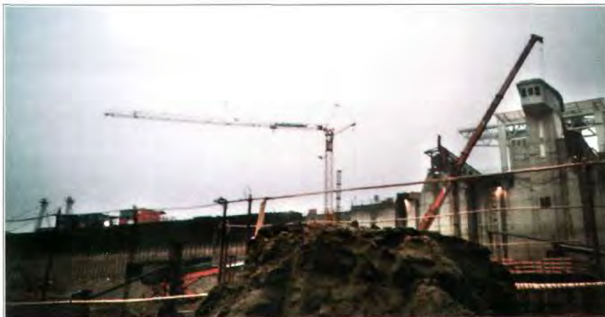
Baustelle des Donaukraftwerkes Freudenau.
