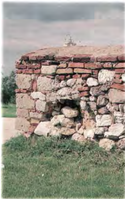
Friedhofsmauer in Fallbach: Fünf verschiedene Bausteine
