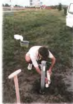
Herstellung einer Grundwassermessstelle und Abdichtung des Ringraumes.
