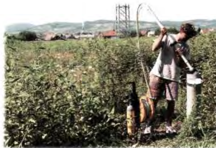
Einbau der Probenahmepumpe. Mittels Doppelpacker
