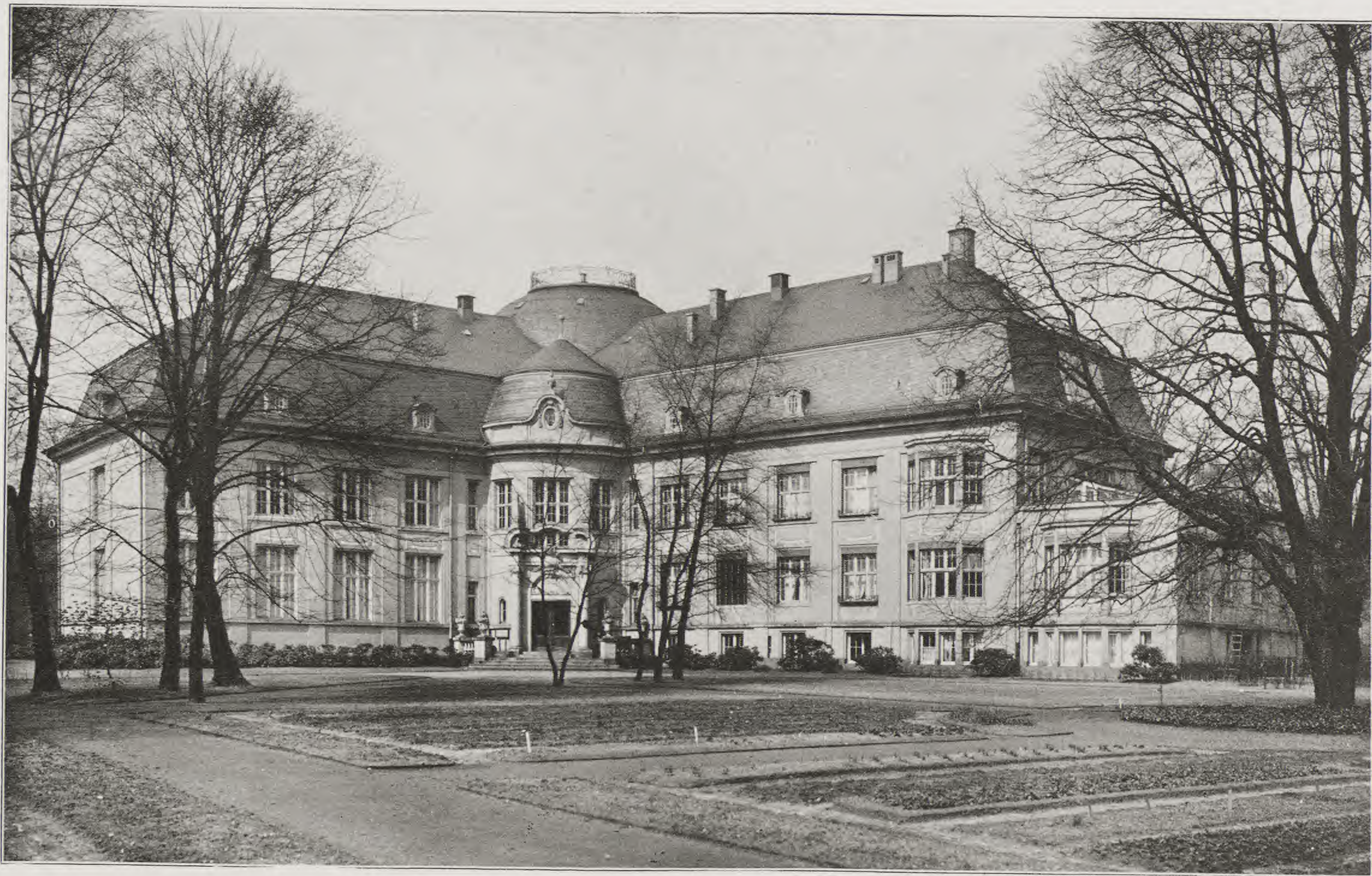
Das Institutsgebäude an der Jungiusstraße (Gartenseite).
