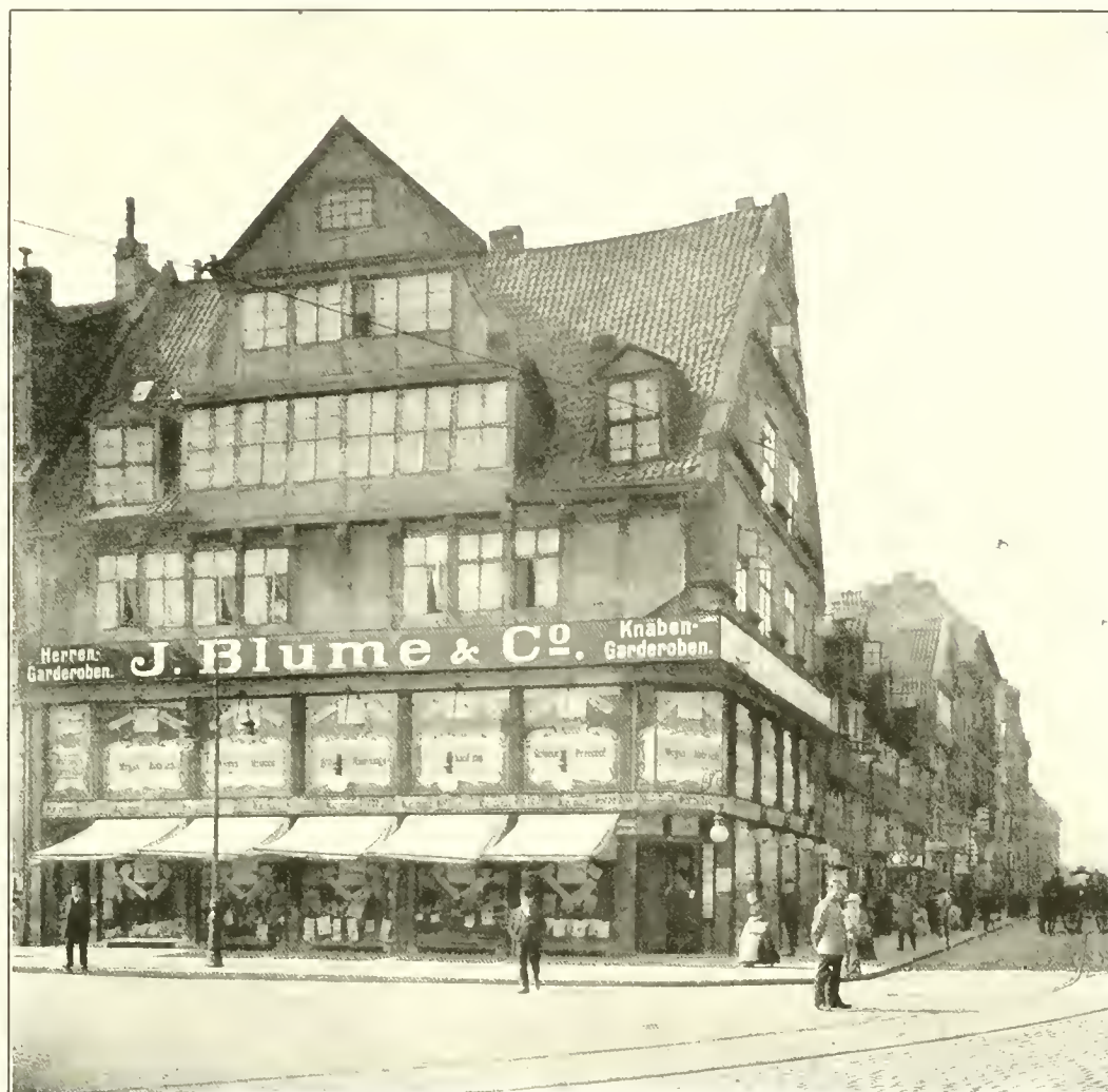
Abb. 4. Ansicht des Hauses Großneumarkt Nr. 32/33 im Jahre 1910.
