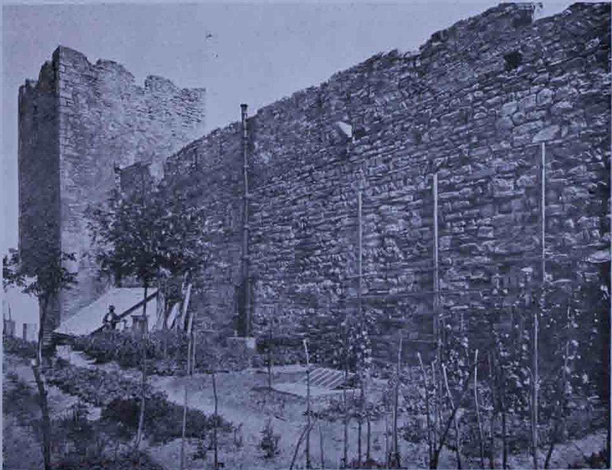
Abb. 19. Turm aus Leopoldinischer Zeit an der östlichen Stadtmauer mit ährenförmigem Mauerwerk (S. 11, 24).
