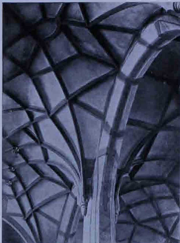
Abb. 14. Purgstall, Pfarrkirche; Netzgewölbe auf Konsolen.
