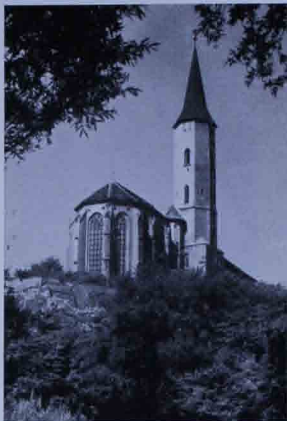
Abb. 18. Klosterneuburg, Martinskirche von Osten; Südturm.
