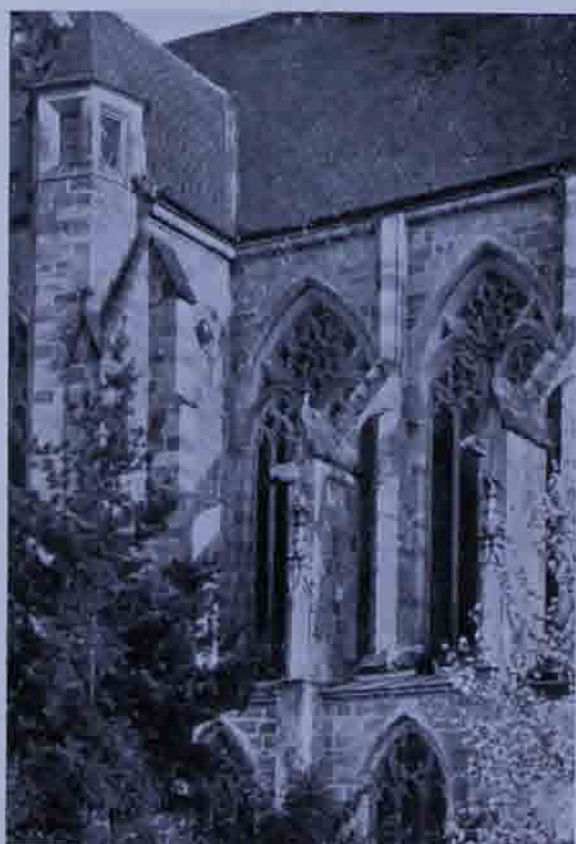
Abb. 20. Zwettl, Chor der Zisterzienserkirche; offene Strebebogen.
