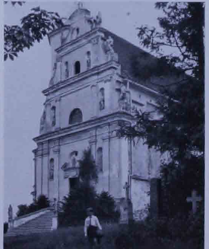
Abb. 16. Falkenstein, Fassade der Pfarrkirche.
