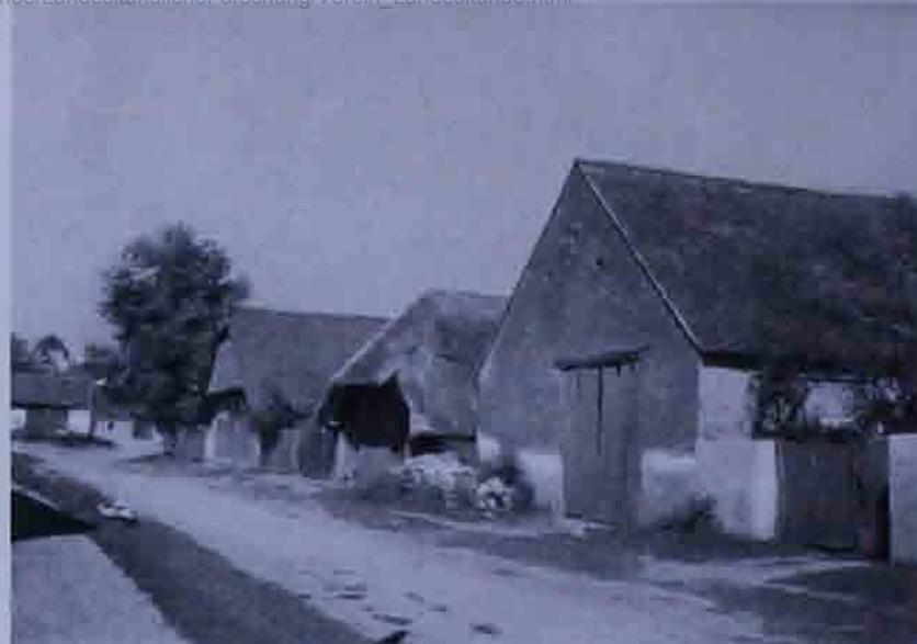
Abb. 3. Scheunenzelle aus Asparn a. d. Zaya. Entwicklungsformen: Mitte Alttype, rückwärts jüngerer Ständerbau, Vordergrund die „feuersichere“ Neuform mit hohen Abseitenwänden.
