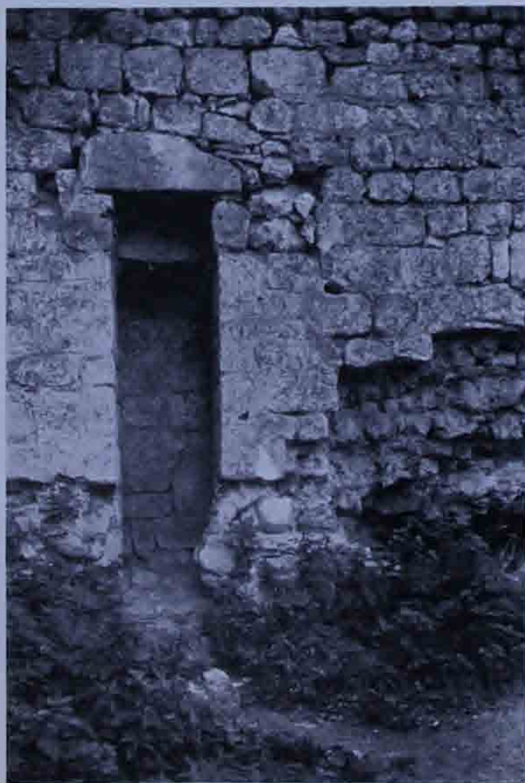
Abb. 3. Ruine Starhemberg, Palas, Nordostwand mit Abtritt. Phot. Halmer.
