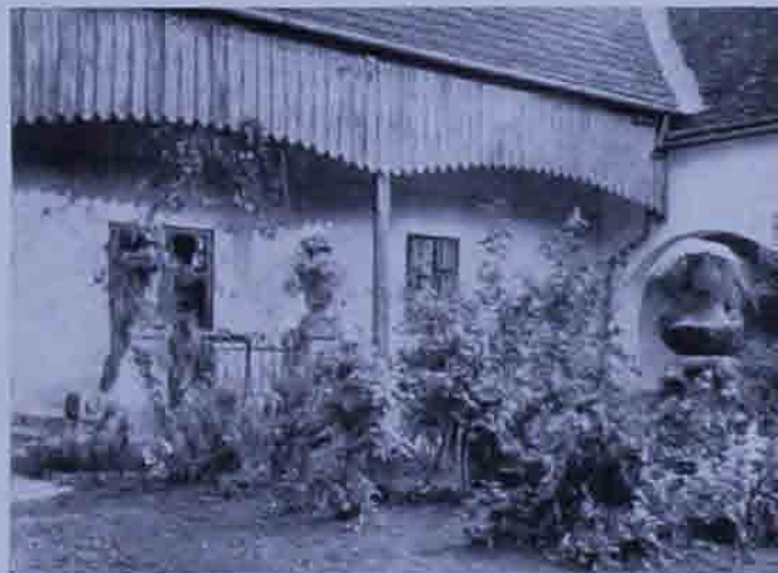
Innenhof des Posthauses in Perschling.
