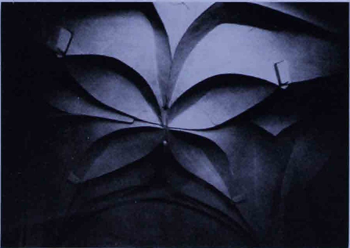
Abb. 2 Breitenreich, Kreissterngewölbe in der Schloßkapelle
