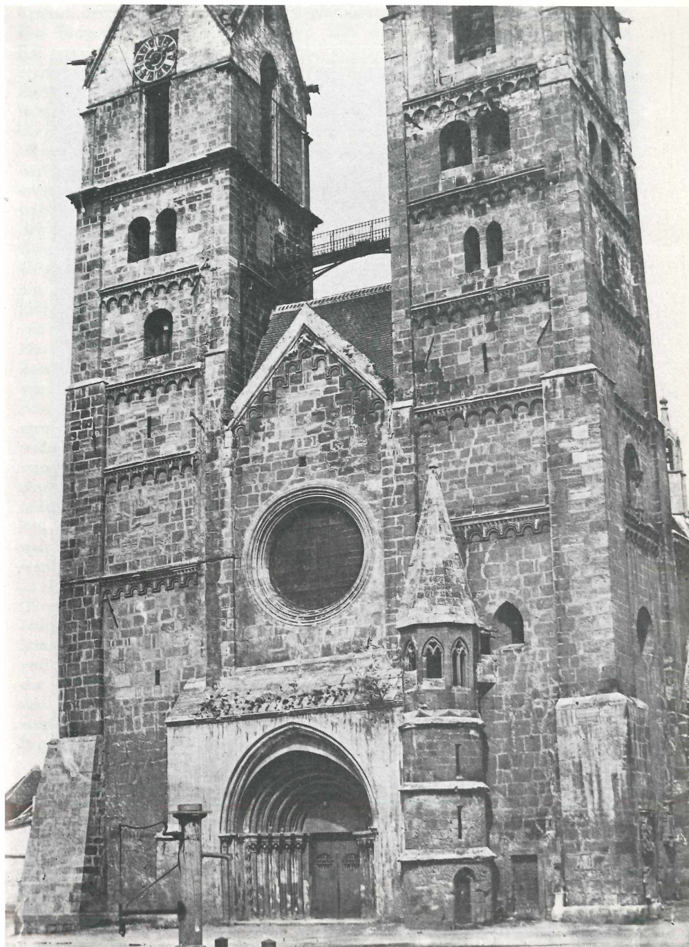
Abb. 15: Wiener Neustadt, Liebfrauenkirche, Westfassade, Zustand vor der Abtragung 1886. Obere Turmabschnitte und Treppentürmchen aus der Bauzeit bis 1279 Photo: Topographische Sammlung des Niederösterreichischen Landesarchivs
