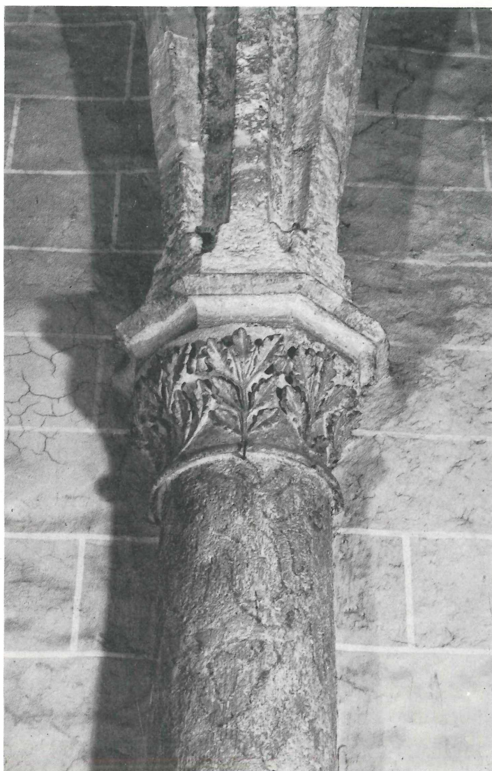
Abb. 1: Krems, Dominikanerkirche, Kapitell eines Gewölbedienstes im Mittelschiff, vor 1265
