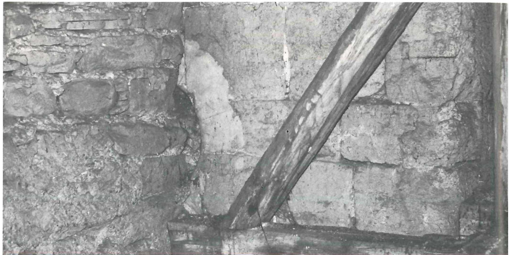
Abb. 3: Romanisches Fenster der ersten Bauphase in der Südmauer des Langhauses.
