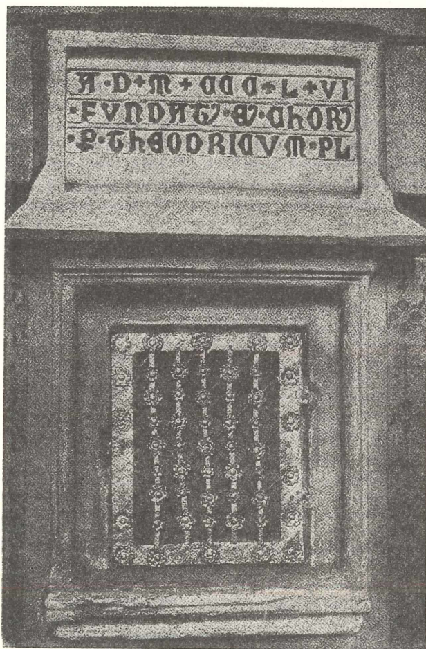
Fig. 9: Kostelzen/Kostelec, Böhmen: Sakramentsnische mit Bauinschrift des Pfarrers Theoderich, der den Chor 1356 begonnen hatte.
