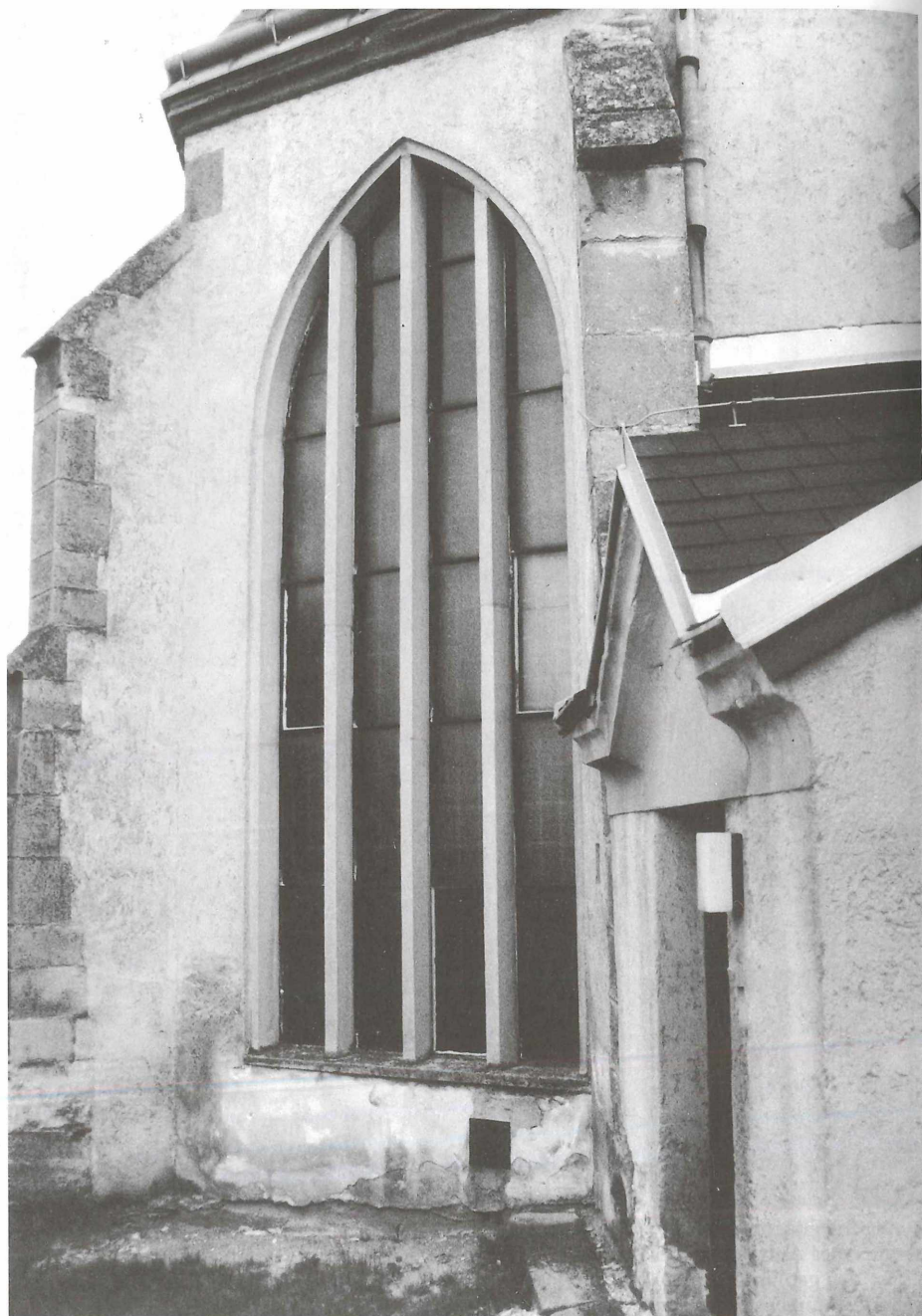
Abb. 3: Pfarrkirche Palterndorf, Betonglasfenster in der nordöstlichen Wand des gotischen Presbyteriums und giebelbekrönter Eingangsvorbau in die ehemalige Kapelle der Rosenkranzbruderschaft als Ergebnis des Umbaus von 1936 durch Karl Holey. Photo: M. Schwarz (1989)
