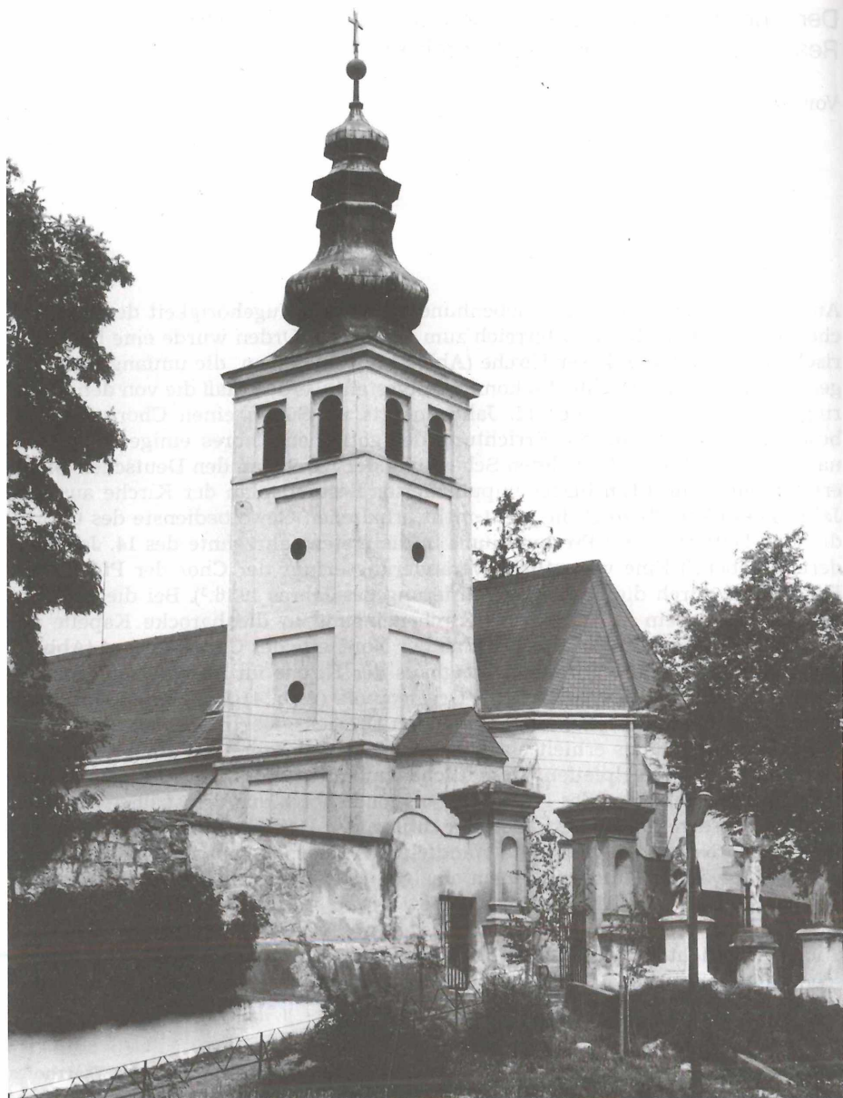
Abb. 1: Pfarrkirche Palterndorf, Ansicht von Südosten. Photo: M. Schwarz (1989)
