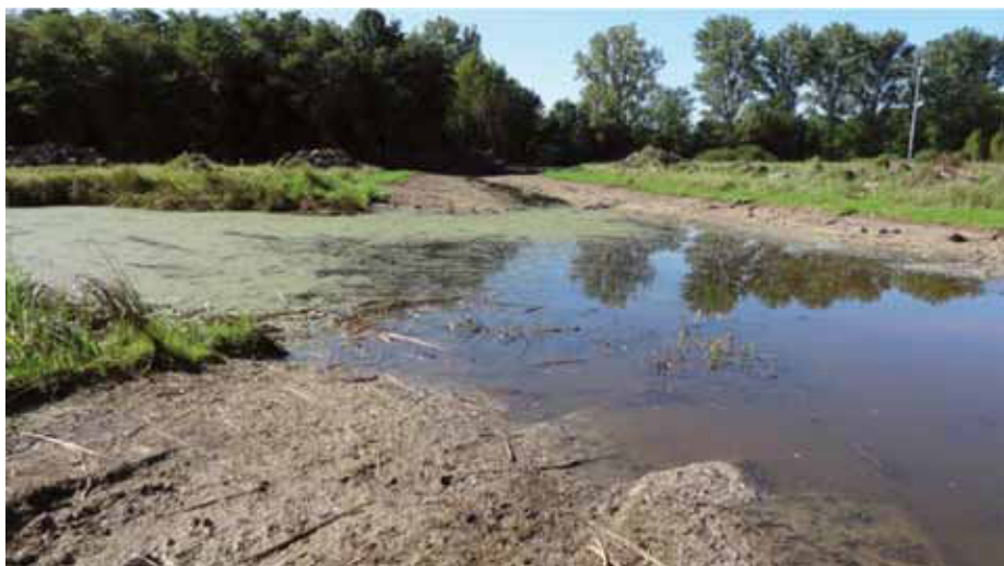
Abb. 2: Grabenabflachung und Anlage von Flutmulden in den „Buschwiesen von Höchst“ Foto: Eichelmann / Schmidt
