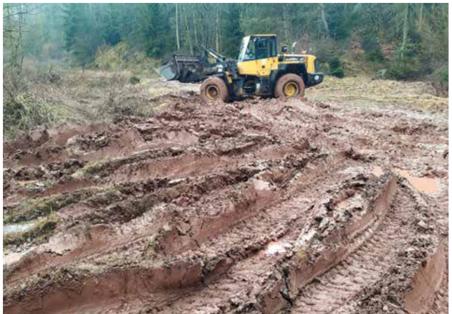
Abb. 2: Radlader beim Verdichten der eingebrachten Tonschicht und Schaffen von Wagenspuren als Gelbbauchunken-Reproduktionsgewässer (Foto: D. Heinz)
