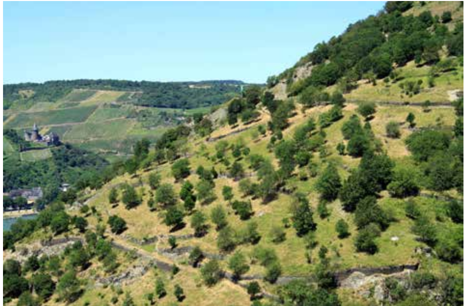
Abb. 2: Wiederherstellung von Trockenmauern im VSG 5912-450 „Weinberge zwischen Rüdesheim und Lorchhausen“ (Foto: W. Mathar)
