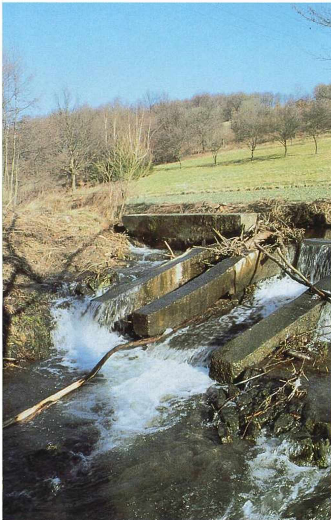
Taf. 12.2 (zu S. 118): Schleifmühlenwehr am Bieberbach vor dem Umbau in eine sogenannte Sohlgleite. Die Wehranlage ist weitgehend verfallen, eine ehe- malige Fischtreppe funktionsunfähig. Ein hoher Sohlabsturz macht das Wehr für Fische unpa- ssierbar.
