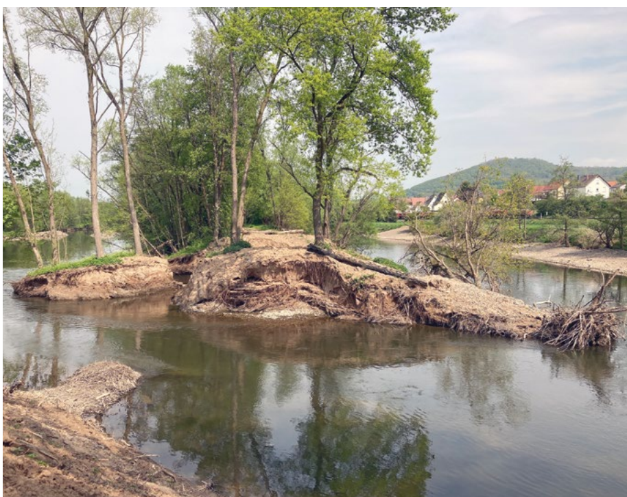
Abb. 3: Untere Eder mit Ansicht eines von vier Durchbrüchen durch den Damm zum sogenannten Schwanenteich. Bereits nach wenigen Wochen wird die eigendynamische Entwicklung der Eder sichtbar. (Foto: C. Henschke)
