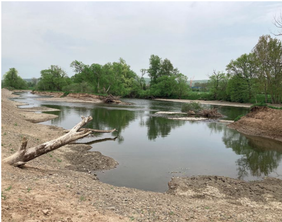
Abb. 2: Untere Eder bei Felsberg mit Darstellung der Gewässeraufweitung und -neustrukturierung. Im Hintergrund ist der alte Lauf zu sehen, am rechten Ufer eine darin neu angelegte Kiesbank. (Foto: C. Henschke)
