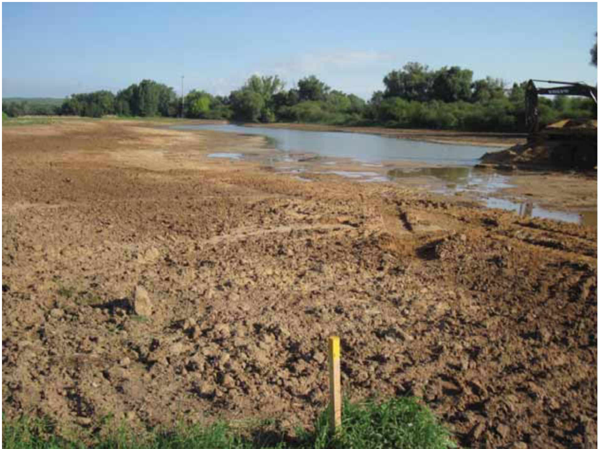
Bauphase im September 2013
