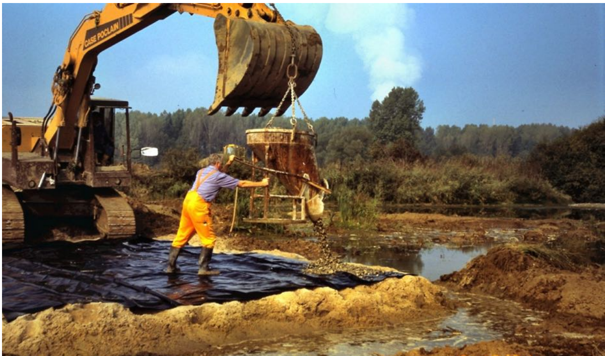
Abb. 1: Die Folie wird auf ein Sandbett gelegt und mit grobem, gewaschenem Kies bedeckt.
