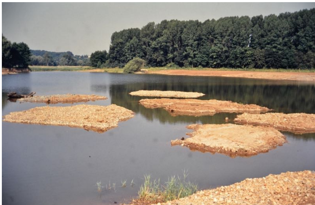
Abb. 3: Kiesinseln unmittelbar nach Fertigstellung.
