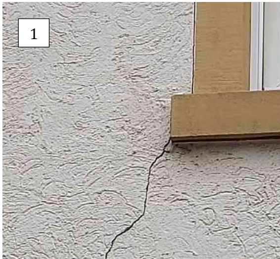
Abb. 1: Rissbildung ausgehend von einer scharfen Kante (Kerbe) im Mauerwerk.
