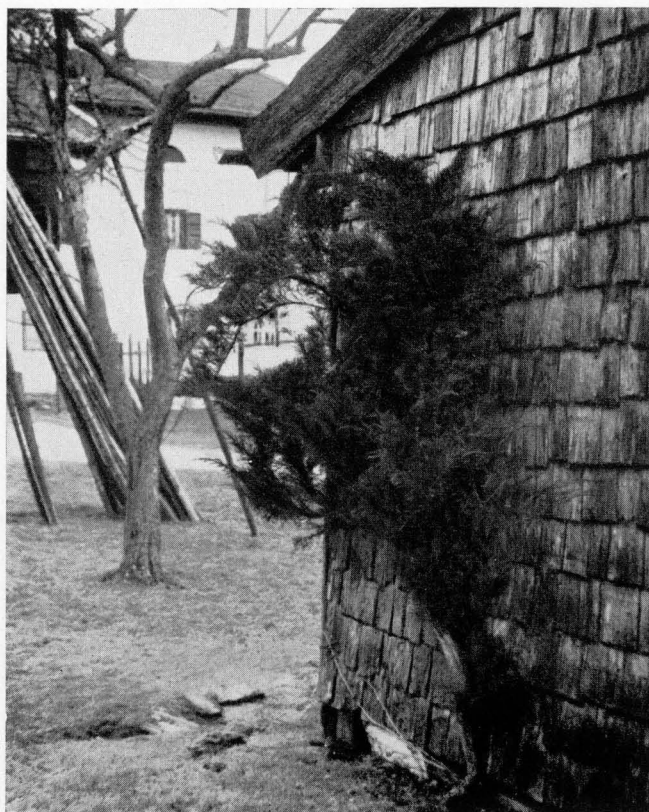
Abb. 2 Sadebaum an geschindelter Stallwand eines oberbayrischen Gehöftes
