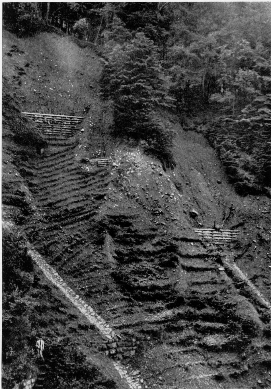
Abb. 6 Sorgfältige Verbauung der Büchel Rübi (Kanton Nidwalden)
