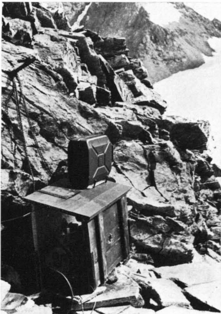
Abb. 4 Der Stromerzeuger zur Energieversorgung der Station ist in der Südwand aufgestellt.
