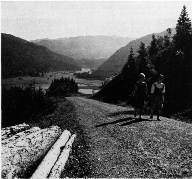
Abb. 14: Beim Forststraßenbau wurde bisher überwiegend auf wirtschaftliche Gesichtspunkte geachtet. Wanderer beschwerten sich über die sehr raue Wegoberfläche und störende Hanganschnitte. Künftig sollte bei Planung und Bauausführung mehr auf die Erholungsfunktion Rücksicht genommen werden. Die „Ein-Funktions-Forststraße“ würde damit zur „Mehr-Funktions-Waldstraße“.
