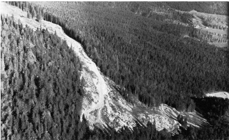
Abb. 22 Dem geschlossenen Fichten-Buchen-Tannenwald kennt man von oben nicht an, wie gefährlich hier die Anlage von Schneisen sein kann. Weil ungünstige Kalke und Dolomite mit karstartiger Entwässerung vorliegen, kam es beim Bau der Skipiste zu unerwarteten Schwierigkeiten. Die beim Planieren entfernte Oberbodenschicht kann sich erst in Jahrhunderten wieder bilden. Die Fläche ist nun schutzlos der Sonne ausgesetzt und bereits stark ausgehagert. Die Begrünung blieb trotz mehrjähriger Bemühungen sehr lückig.
