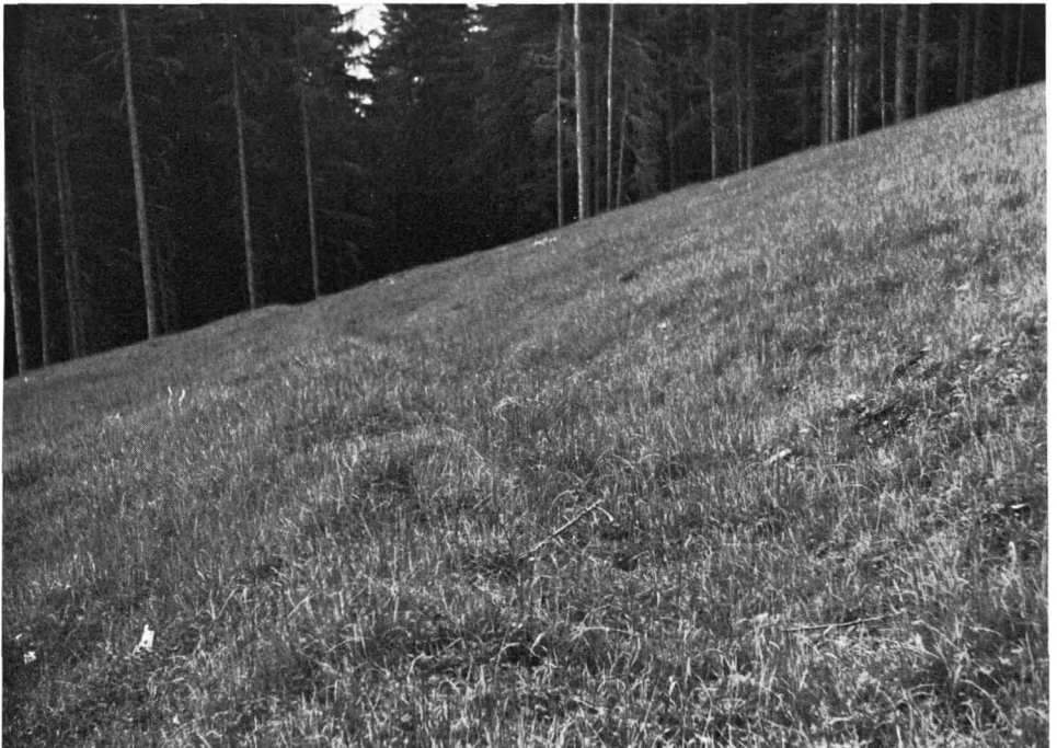
Abb. 16 Entwässerungsgraben in einer Skipiste, durch die Berasung kaum mehr erkennbar. Keine Erosionsschäden, kein Hindernis für die Skifahrer.
