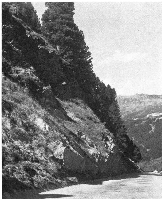
Abb. 3 Trotz umfangreichen Felsabtrages vorbildlich angelegte und begrünte Wegschneise an der Waldgrenze der Zentralalpen.
