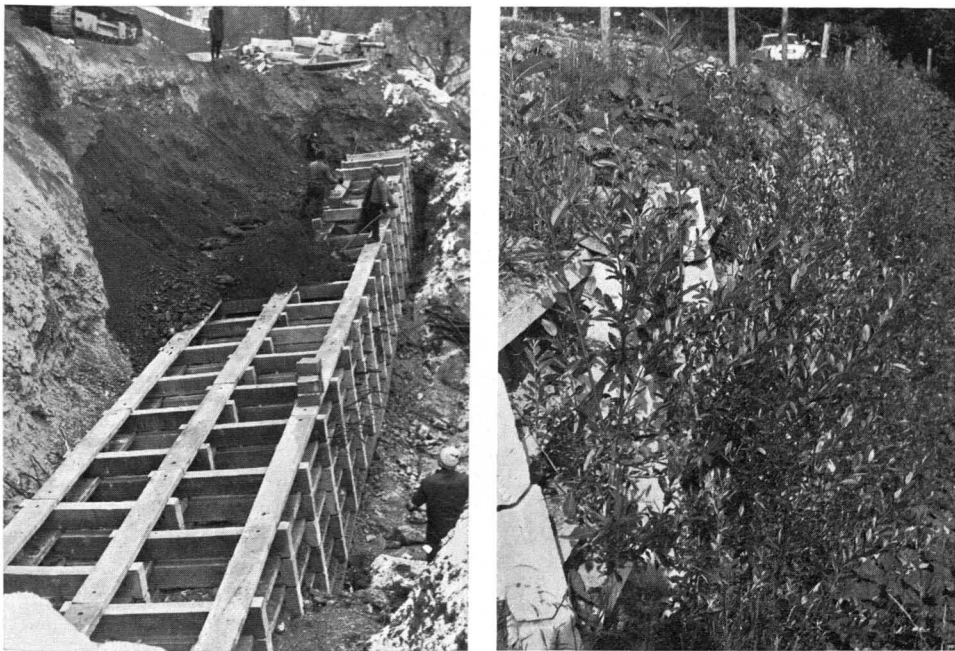
Abb. 18 Abstützung eines Böschungsfußes durch Krainerwand aus Beton-Fertigteilen. Die Krainerwände wurden durch Einlegen von Weidenästen begrünt (am Vergleichsbild nach 2 Jahren). Die Bauwerke werden dadurch in das Landschaftsbild eingefügt und bei Holzbauten deren Lebensdauer erhöht.
