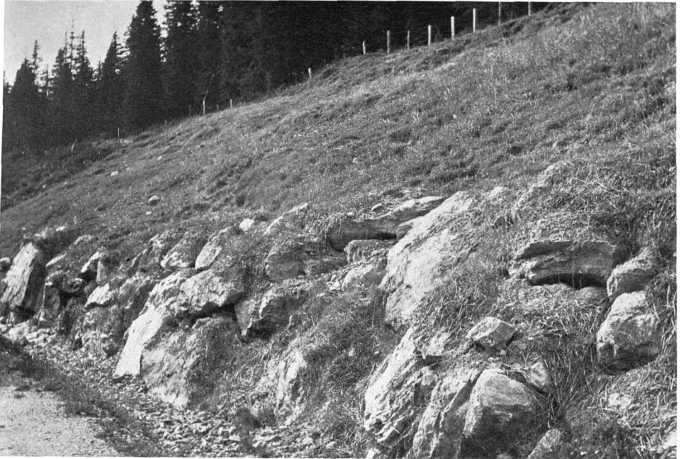
Abb. 19 Abstützung eines vernäßen Böschungsfußes durch Blockschichtung. Hinterfüllung mit Filterkies, Begrünung mittels Mulchsaat.
