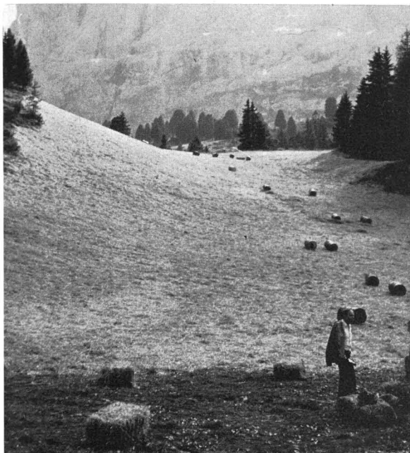
Abb. 2 Skipistenbau an der Waldgrenze. Gute Anpassung an die unberührte Vegetation mit Erhaltung sturmsicherer Baumgruppen, Begrünung mittels Schiechteln.
