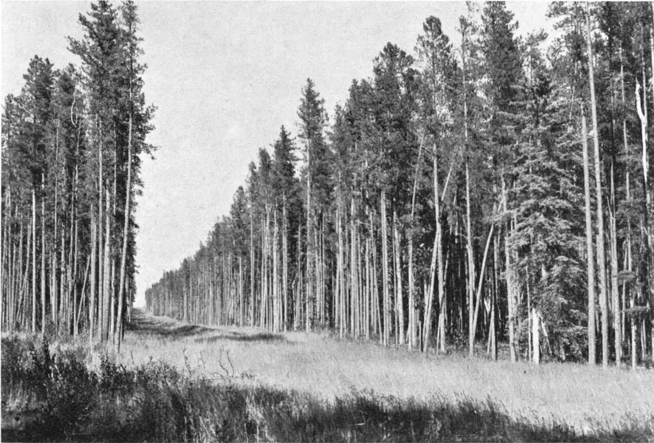
Abb. 6 Pipeline in Nord-Kanada, zum Erosionsschutz begrünt. Diese Schneisen sind natürlich sehr anfällig gegen Windwürfe. Schief stehende Bäume sind bereits erkennbar.
