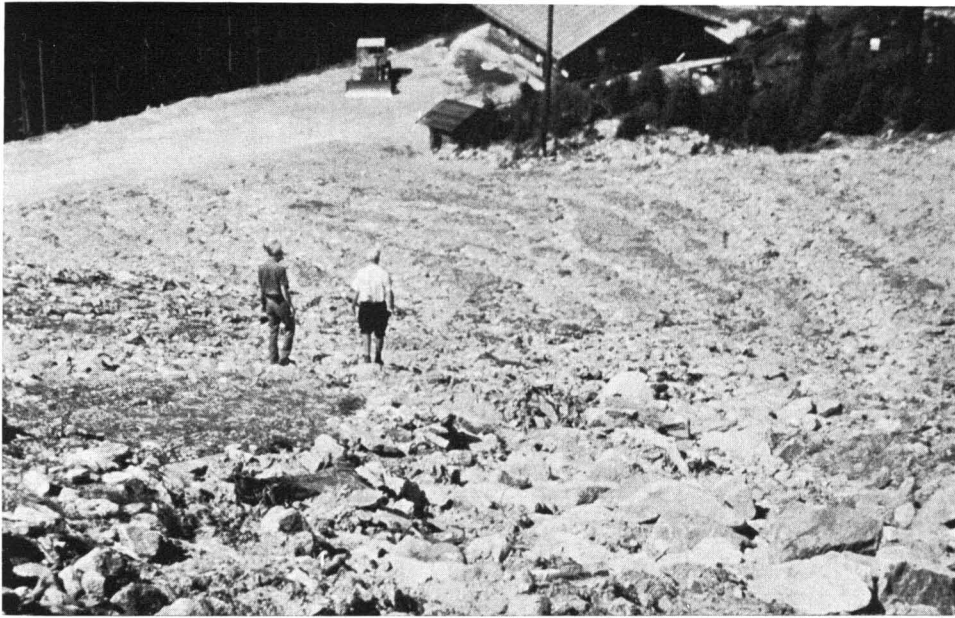
Abb. 17 Durch Verzicht auf Entwässerungsgräben kam es in dieser Skipiste zu schweren Erosionsschäden. Das Feinmaterial wurde abgeschwemmt, Waldbestände, Wege und Hotels vermurt.
