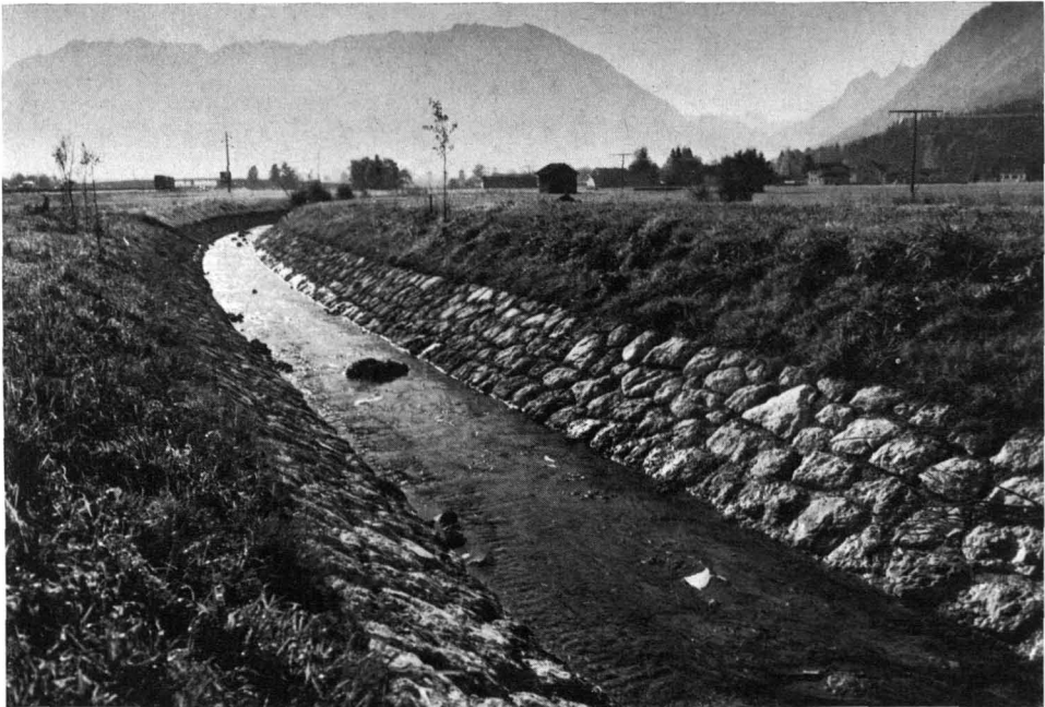
Abb. 21 Solche Bachverbauungen sollten der Vergangenheit angehören. Die Wildbachverbauung der letzten Jahre gibt zu der Hoffnung Anlaß, daß befriedigende Lösungen gefunden werden.
