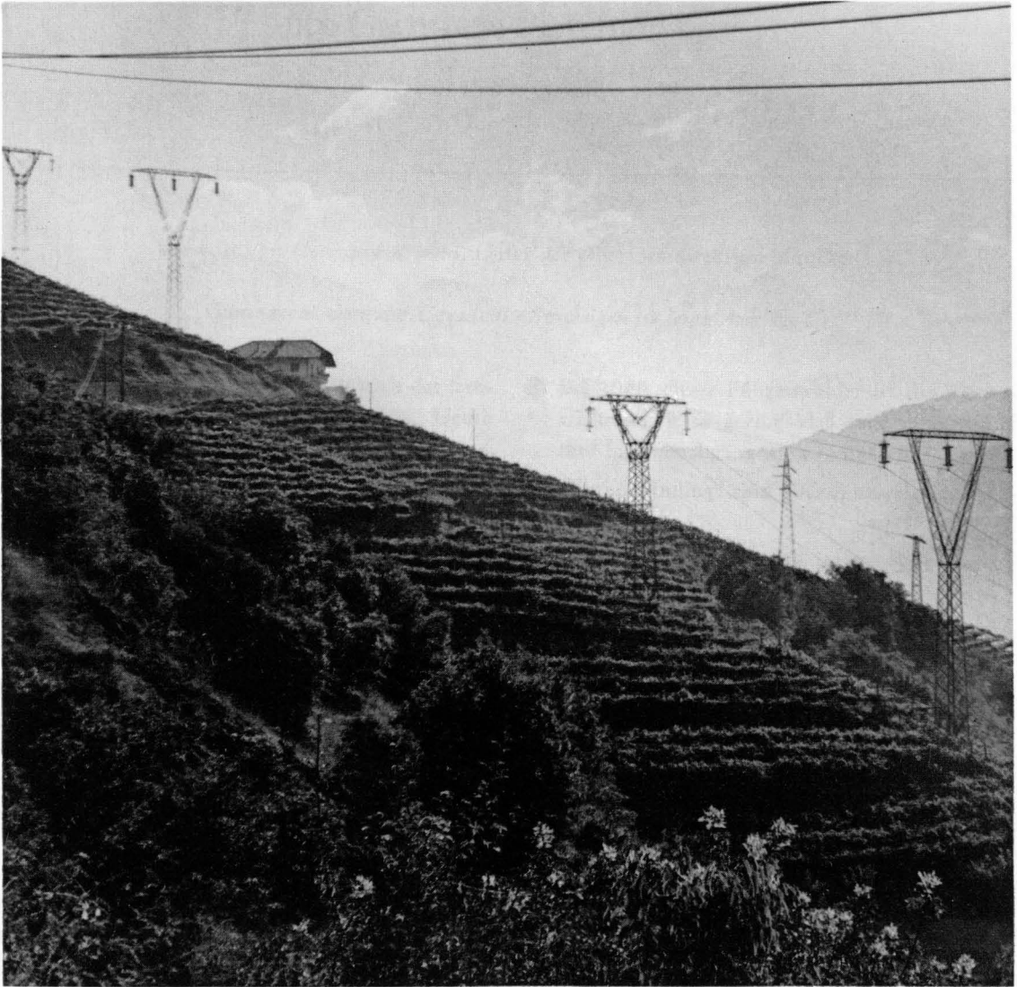
Abb. 6 Regenerierbare Energiequellen in den Bergländern sind im Rahmen regionaler oder örtlicher Energieversorgungskonzepte umweltfreundlich zu erschließen. Die hierzu notwendige Forschung und Planung ist vordringlich voranzutreiben.
