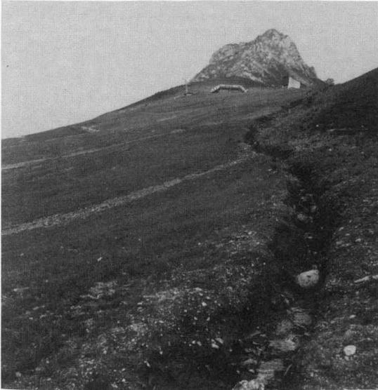
**Bild 11** Planierte Skipisten in den Allgäuer Hochalpen mit Drainagegräben. Bemerkenswert ist die rasche Tiefenerosion der Gräben ohne Schotterverfüllung, die zu einer Beschleunigung des Oberflächenwassers beiträgt.
