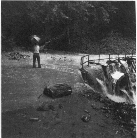
**Bild 12** Schädigung der Wasserrückhaltefunktion von Boden und Vegetation führen zu einer extremen Beschleunigung des Oberflächenwassers. Bei hohen Niederschlägen sind oftmals auch technische Stabilisierungseinrichtungen überfordert und wirkungslos.
