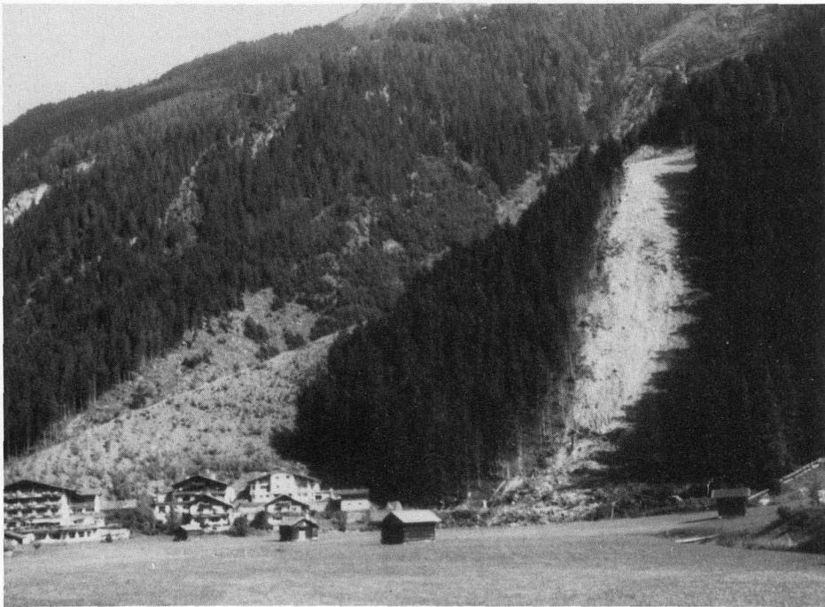
Bild 8 Das Bild zeigt den Ortsteil Krößbach 1985 im Schutz des neuen Lawinendammes und eine im August 1985 nach einem 3tägigen Landregen abgegangene Rutschung, die eine breite Schneise in den Schutzwald schlug — Ansatz für neue Lawinen.
