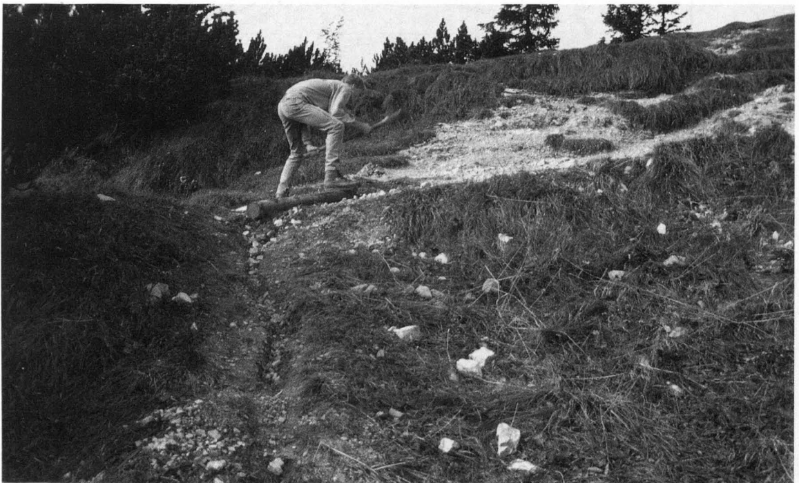
Abb. 7: Erosionsansatz unterhalb einer Wasserauskehre.
