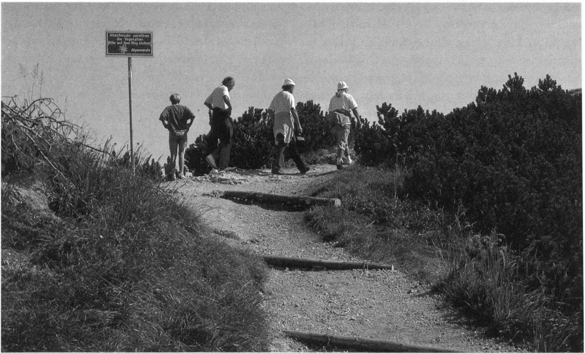
Abb. 2: Am Weg eingebaute Wasserauskehren aus rohen Nadelholzstangen.
