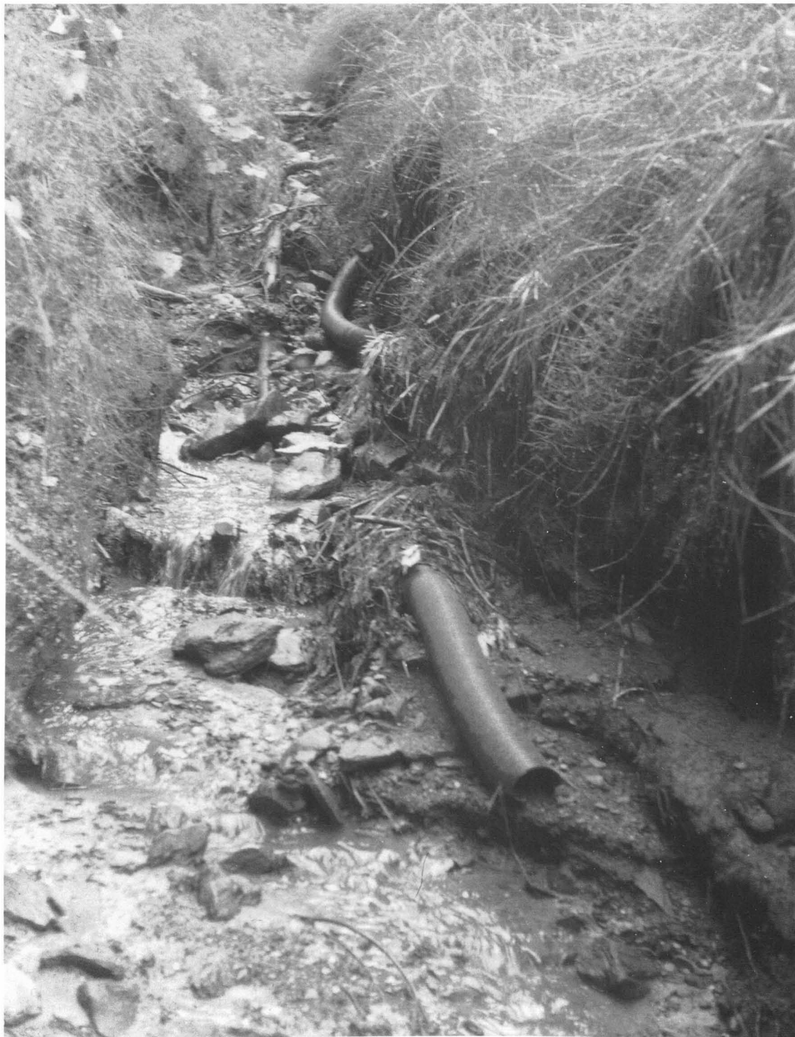
Abb. 4: In den eigentlichen Drainagegräben liegen die Rohre wie Spielzeugteile umher. Ein schweres Gewitter anfangs August 1991 schaffte am bergseitigen Hang des künstlichen Sees gewaltige Erosionsarbeit, und starke Einschwemmung trübte ihn langfristig ein.
