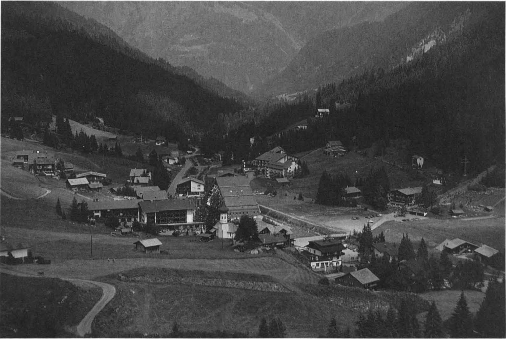
Foto 8: Gargellen 1989, Blick nach Norden. Im Vordergrund Lawinleitdämme der Alptobellawine zum Schutz des Ortszentrums. Am re. Bildrand (Mitte) Lawinleitdamm der Kälberhaldenlawine zum Schutz des Hotels „Heimspitze“. Standort: Höhenweg orographisch li. Seite, 1500 m ü. NN (Aufnahmedatum 26.07.1989)
