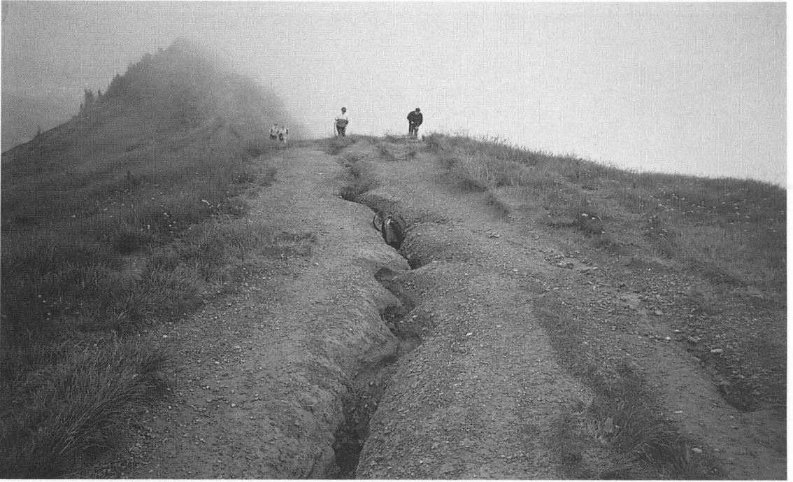
Foto 5: Fortgeschrittener Schädigungsprozess: 4 Meter breiter Weg, bis 50 Zentimeter tiefe Erosionsrinnen. (Weg vom Fellhorngipfel zur Söllereckbahn, Sommer 1990)
