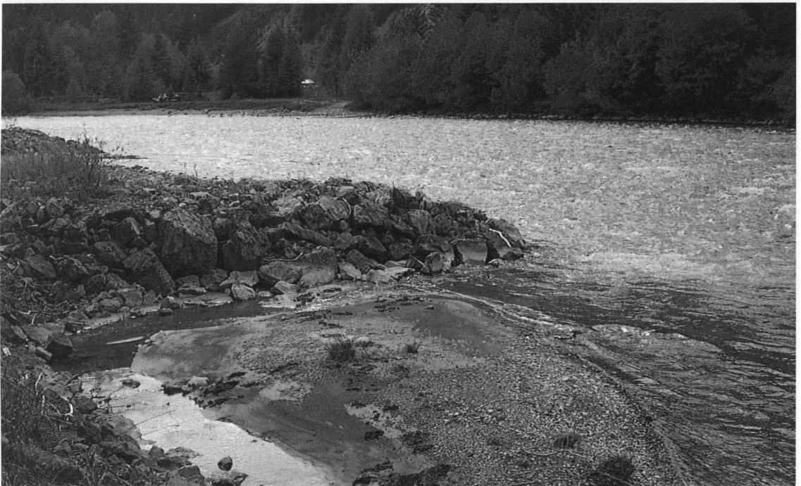
Abb. 7: Aus heutiger Sicht wasserbaulich wie umweltschützerisch unverständliche Baumaßnahmen wie diese Bühnen zerstören die letzten Verzweigungsstrecken des Tiroler Lech.
