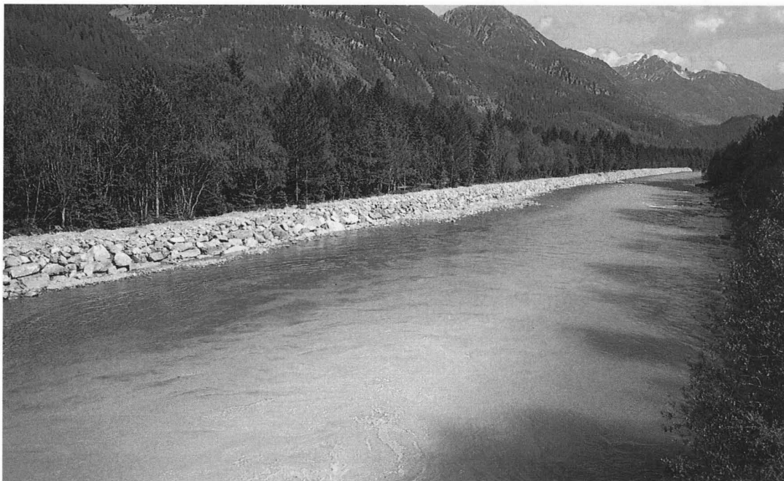
Abb 8: Das Ergebnis der flußbaulichen Eingriffe ist ein kanalartiges Gerinne, in dem sich der Lech rasch eintieft und damit fortlaufend neue Baumaßnahmen verursacht.
