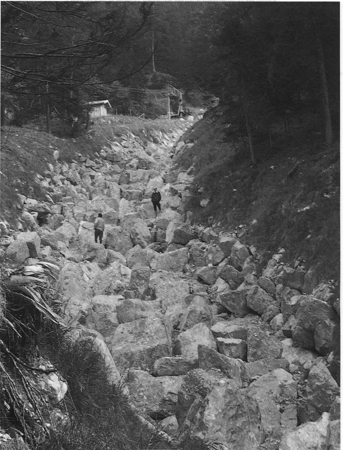
Abb. 26: Heute ermöglichen schwere Baumaschinen die Nachahmung blockierfüller, stabiler Bachstrecken. Solche Bauwerke können unter bestimmten Voraussetzungen Sperrentreppen ersetzen.
