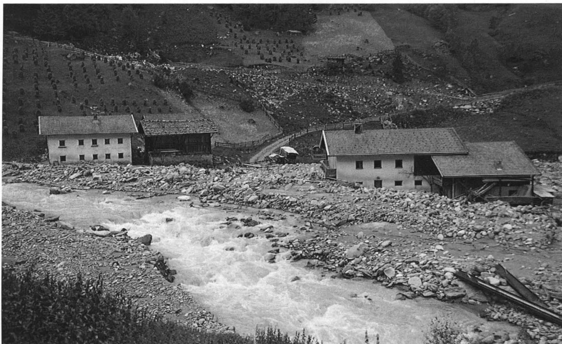
Abb. 18: Auch alte Bauernhäuser sind bei Extremereignissen wie hier 1987 im Stubai vor Hochwasserschäden nicht sicher.
