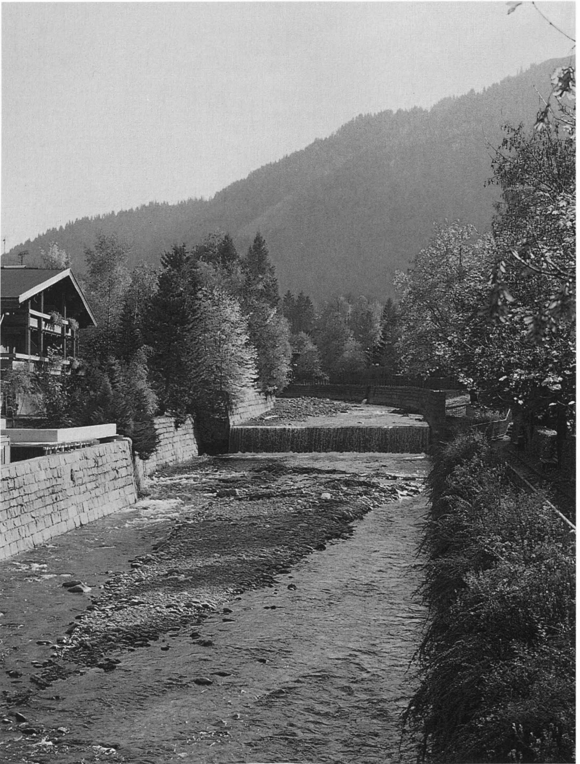
Abb. 22: In stark besiedelten Talräumen können oft nur Mauern den menschlichen Lebensraum vor Hochwasser schützen.
