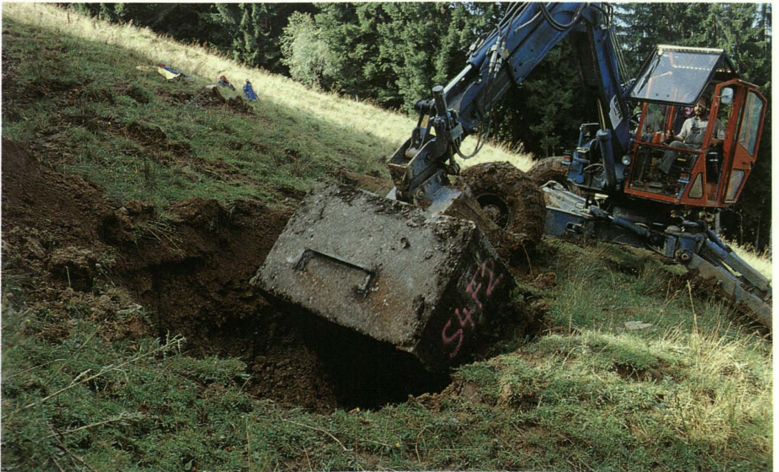
Foto 15: In geeignetem Gelände werden ganze Stützfundamente vergraben, um unnötige Transporte zu vermeiden.
