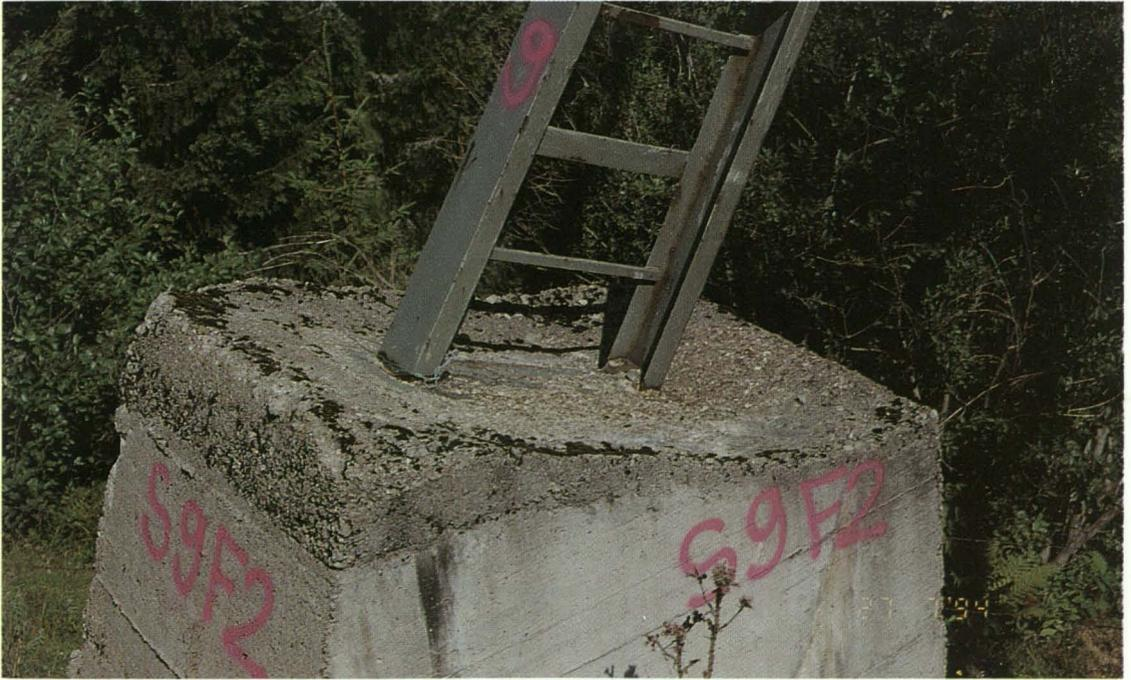
Foto 3: Liftstütze mit Fundament aus Stahlbeton.
