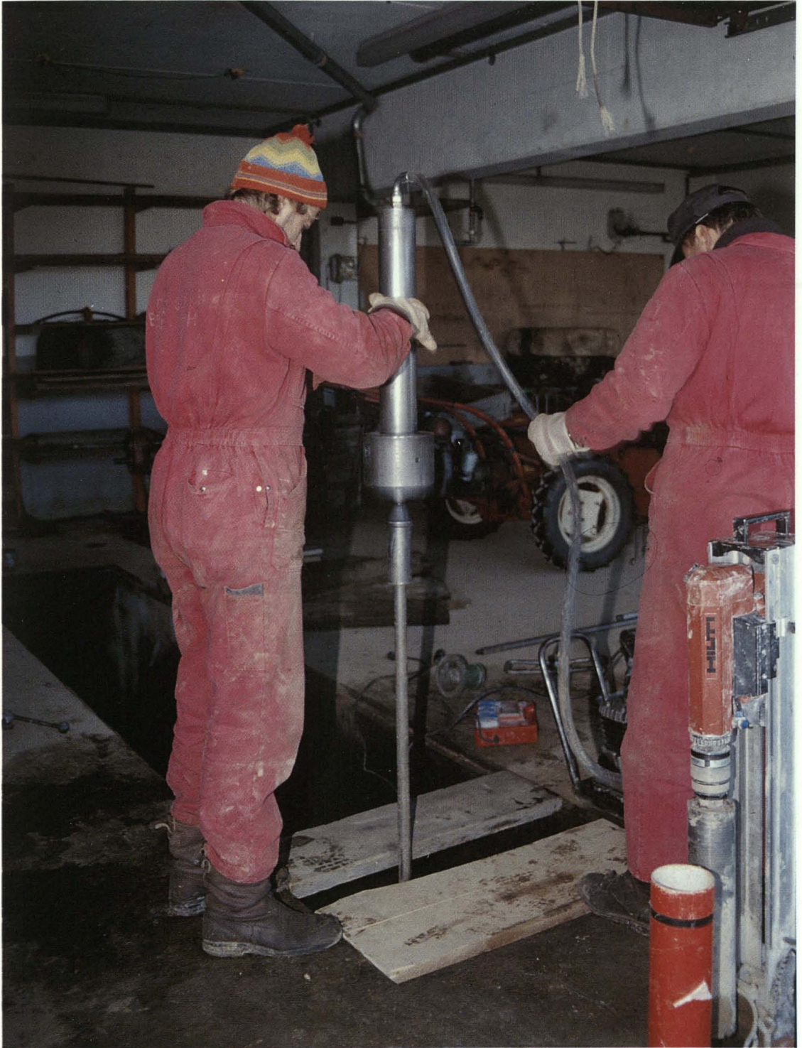
Foto 21: Im Rahmen der altlastentechnischen Untersuchung werden zur Abgrenzung der Bodenverunreinigung Rammkernsondierungen niedergebracht.
