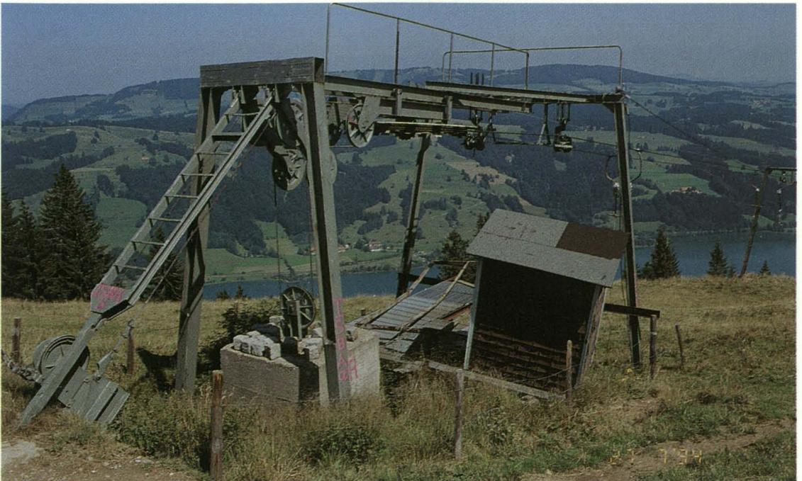
Foto 4: Die Bergstation von Lift I mit liegend gelagerter Umlenkscheibe, Spannwagen, Spannungsgewicht und Kontrollkabine an der Ausstiegsstelle.
