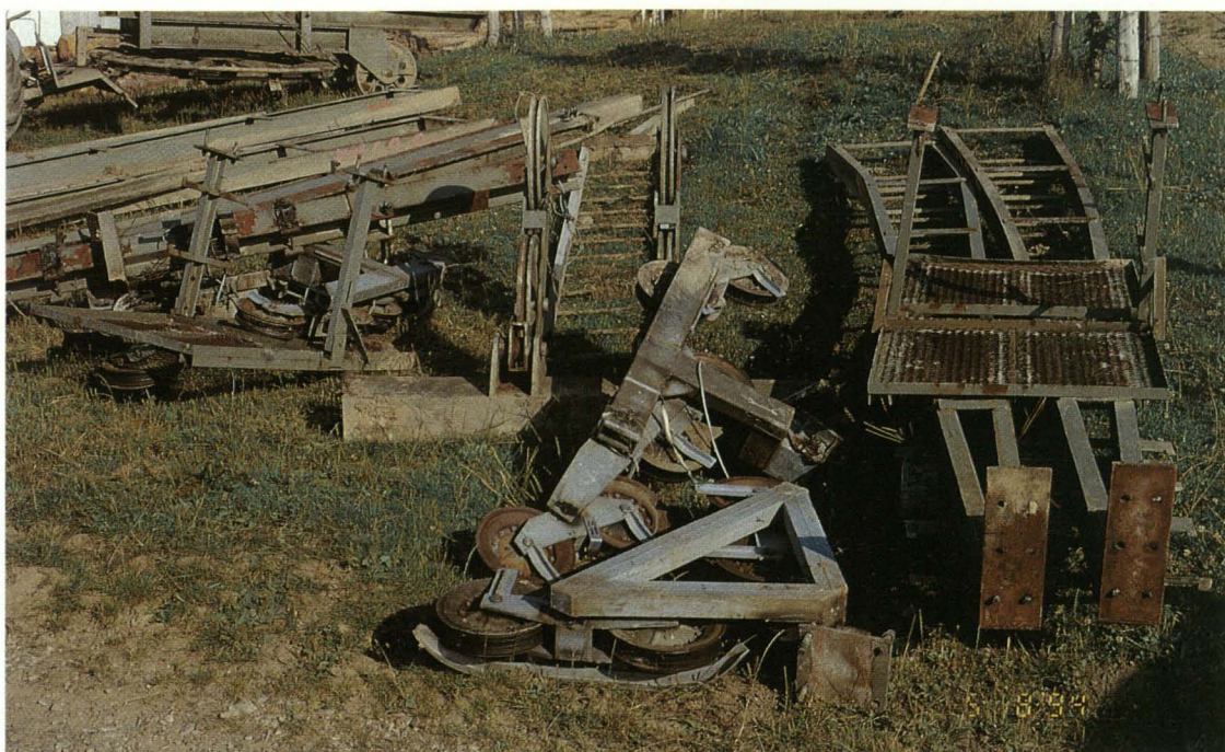
Foto 11: Zerlegte Liftstützen vor dem Abtransport ins Tal.
