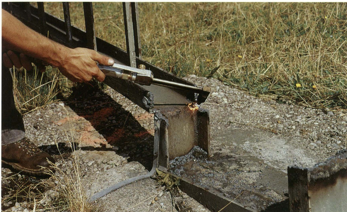
Foto 10: Die Liftstützen werden in einzelne Teile zerlegt und abtransportiert.
