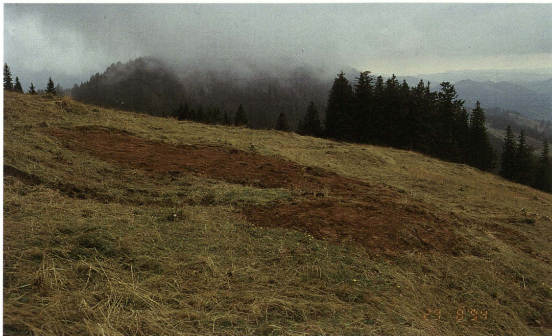
Foto 17: Das Bild zeigt den humusierten ehemaligen Standort einer Liftstütze mit zwei bis unter die Bodendecke abgetragenen Stützfundamenten.
