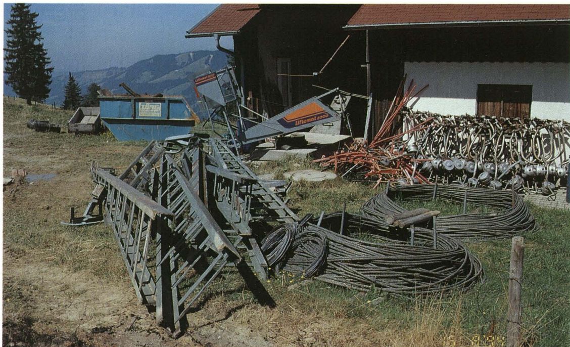
Foto 12: Die Seile, Gehänge und Schleppbügel können teilweise wiederverwendet werden.
