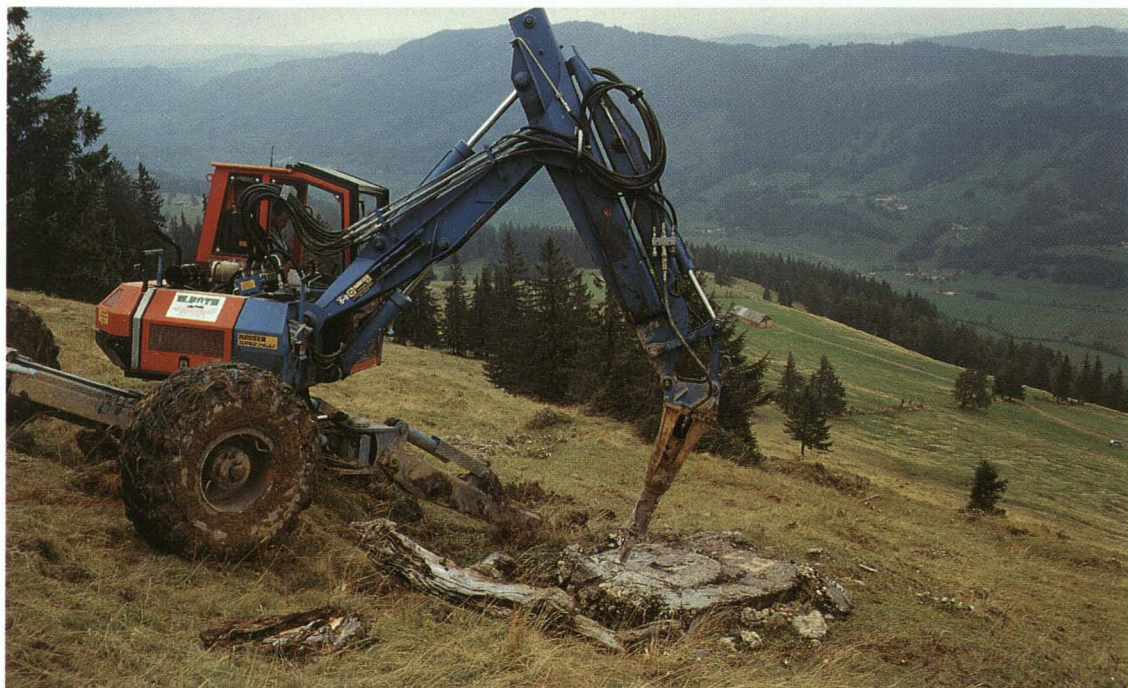
Foto 13: Die Stützfundamente aus Stahlbeton werden von einem Spezialbagger mit einem Meisel zertrümmert.
