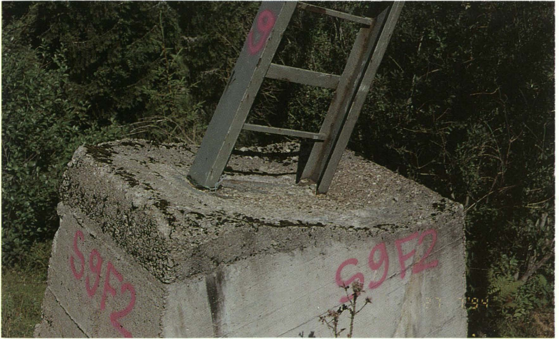
Foto 3: Liftstütze mit Fundament aus Stahlbeton.
