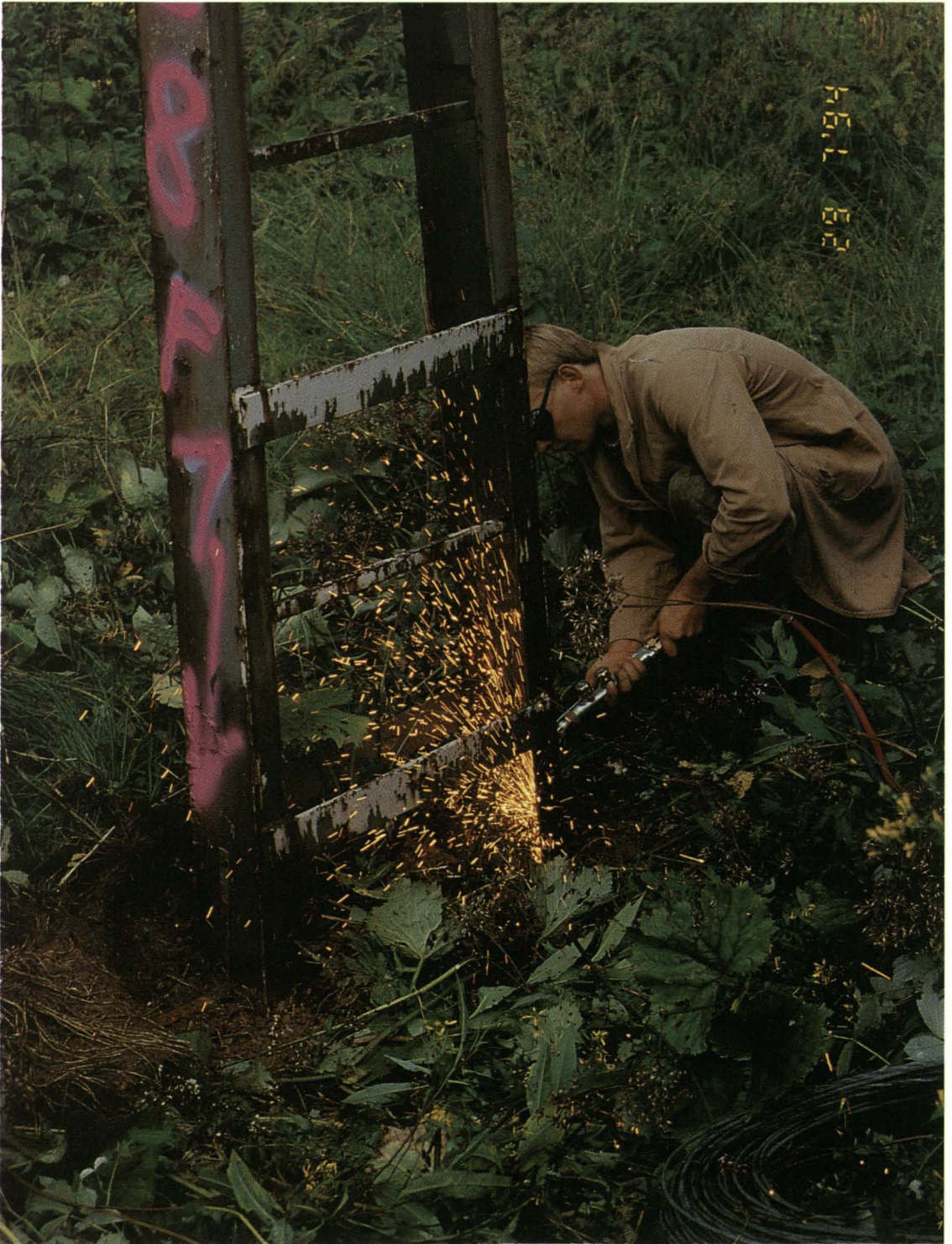
Foto 9: Der oberirdische stählerne Teil der Liftstützen wird mit einem Schneidbrenner abgetrennt.
