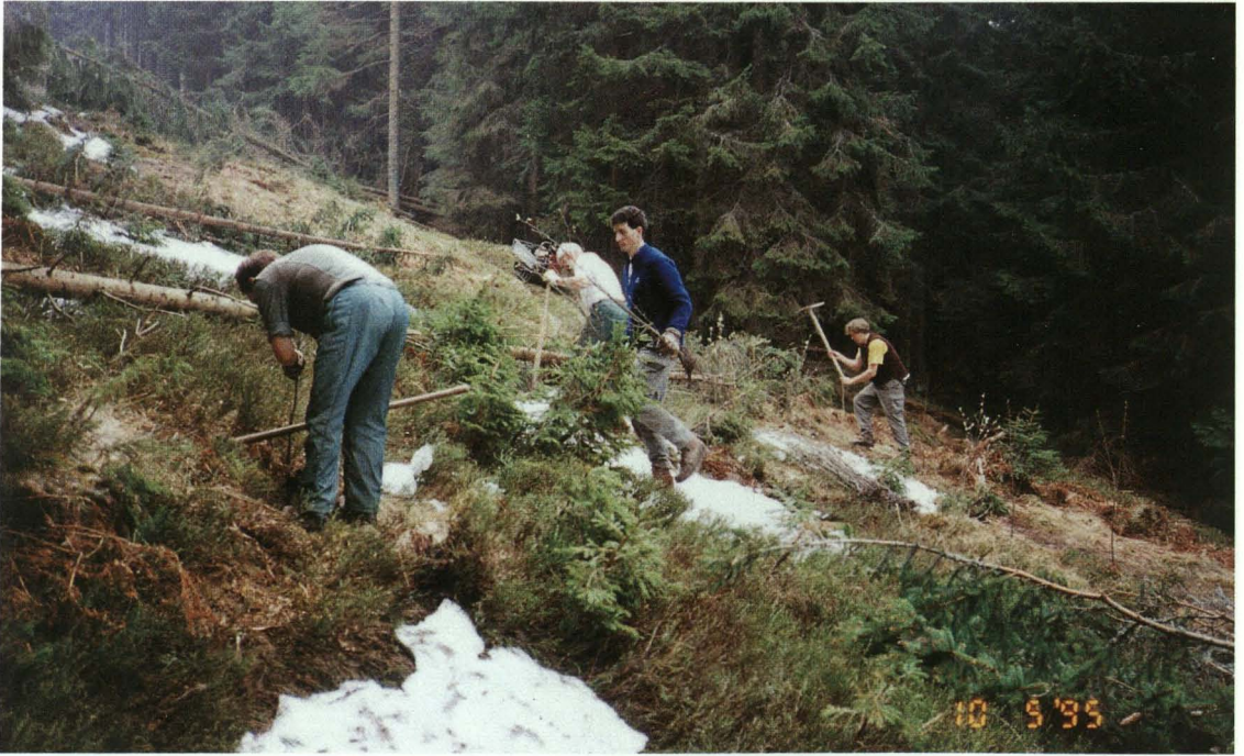
Foto 27: Mit den Aufforstungsarbeiten in der ehemaligen Liftrasse wurde im Frühjahr 1995 begonnen
