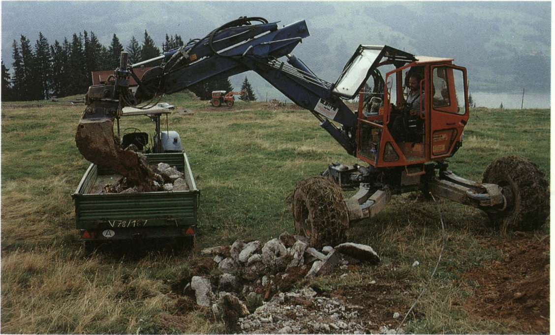
Foto 14: Anfallender Bauschutt wird entweder aus der Fläche verbracht oder eingegraben.
