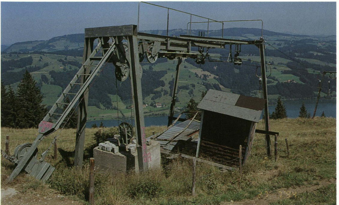
Foto 4: Die Bergstation von Lift I mit liegend gelagerter Umlenkscheibe, Spannwagen, Spannunggewicht und Kontrollkabine an der Ausstiegsstelle.
