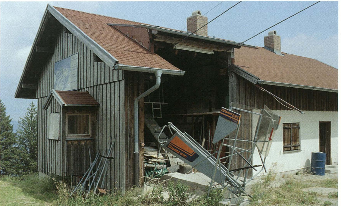
Foto 6: Die Talstation von Lift II . Im offenen Teil des Gebäudes befindet sich die Umlenkstation und der Motor.
