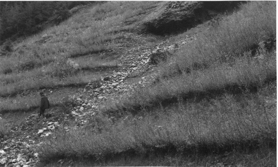
Abb. 5: Ingenieurbiologische Sanierung eines Rutschanges durch Gehölzpflanzung in Kombination mit technischer Verbauung. Langfristiges Ziel ist eine stabile Wiederbestockung der Fläche
