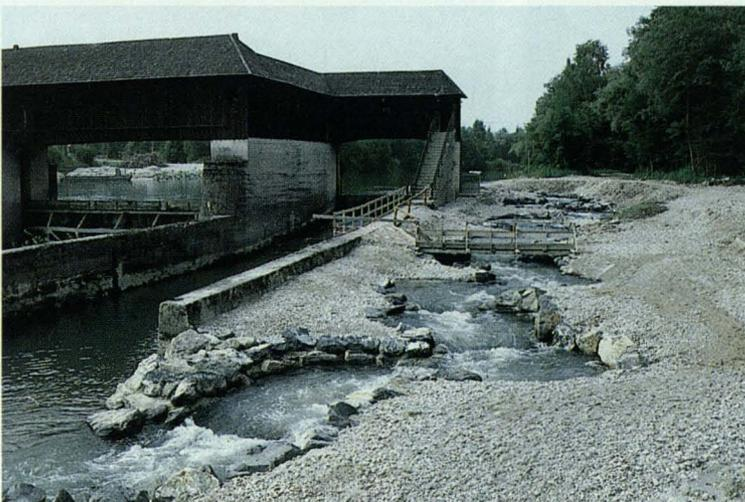
Abb. 11.19: Wehranlage Icking mit neugestaltetem Fischpaß 1996.
