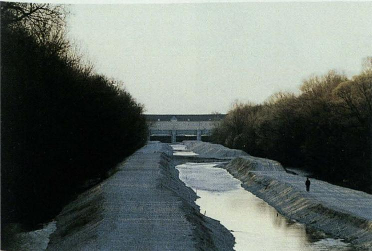
Abb. 11.16: Wehranlage Oberföhring; aus dem Stauraum in das Unterwasser umgesetztes Geschiebe.
