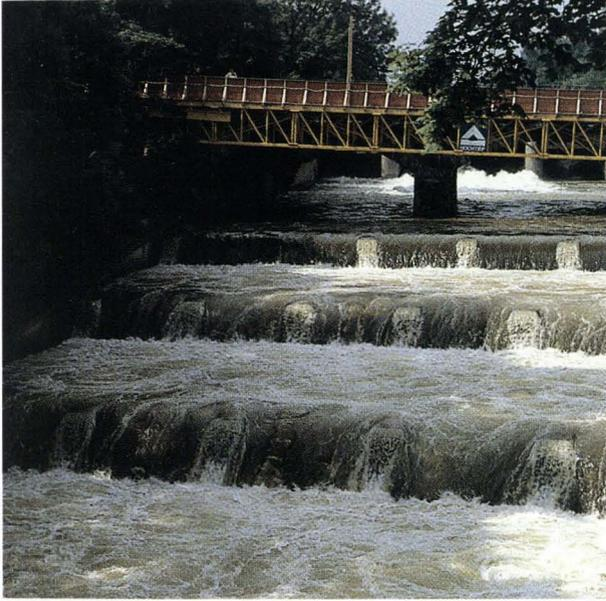
Abb. 3.19: Bei Hochwasser wird ein Teil des Abflusses in die „Kleine Isar“ abgeworfen.
