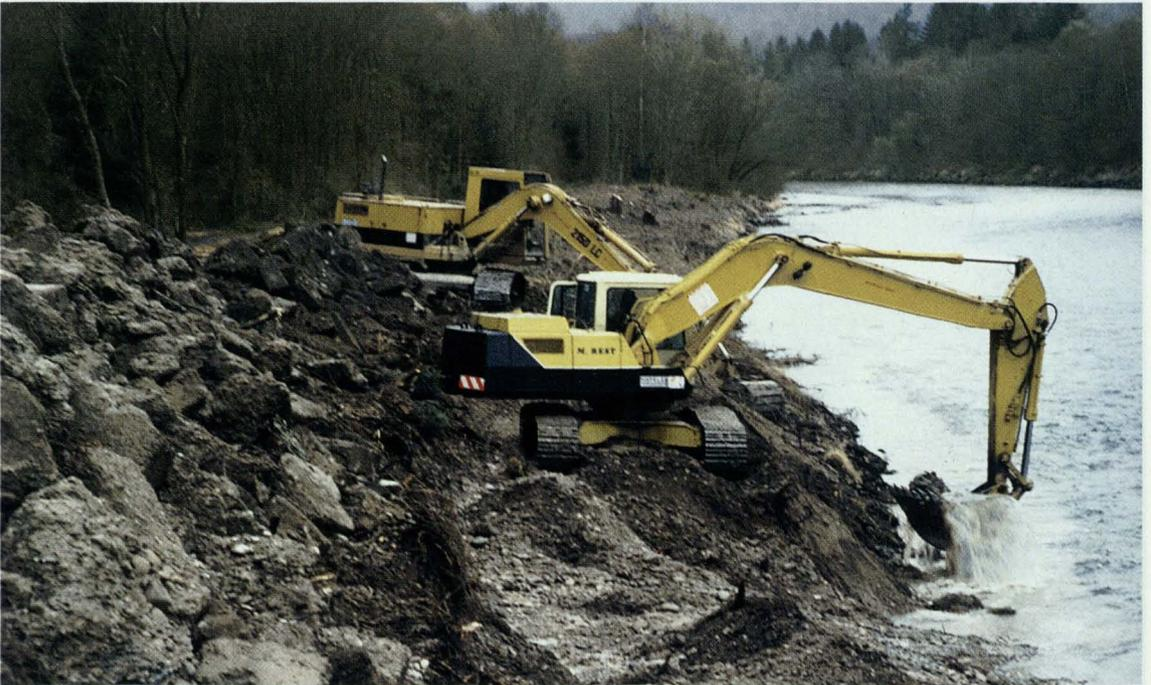
Abb. 11.8: Nach Rodung der Ufergehölze, Entnahme der Betonplatten
