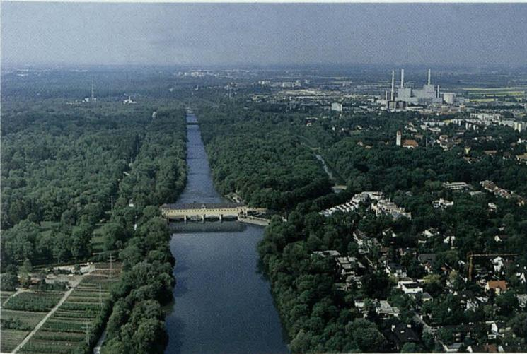
Abb. 11.15: Isar, Oberföhringer Wehr; aus dem Stauraum wurde 1996/97 das Geschiebe ins Unterwasser verbracht.
