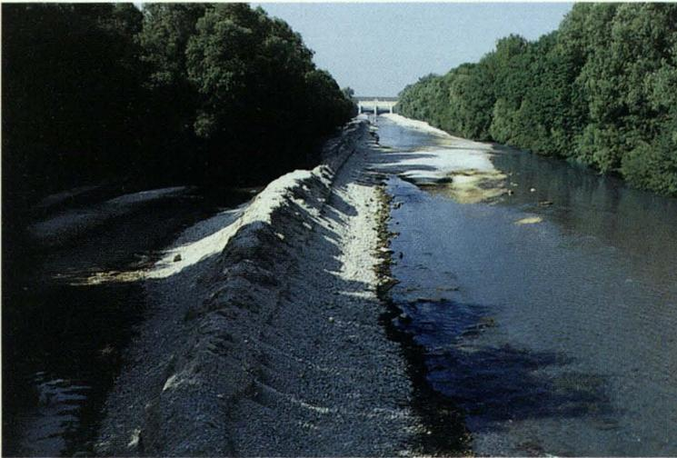
Abb. 11.17: Innerhalb von wenigen Wochen wurden die umgesetzten Kies- und Sandmassen von der Isar weiterverfrachtet.
