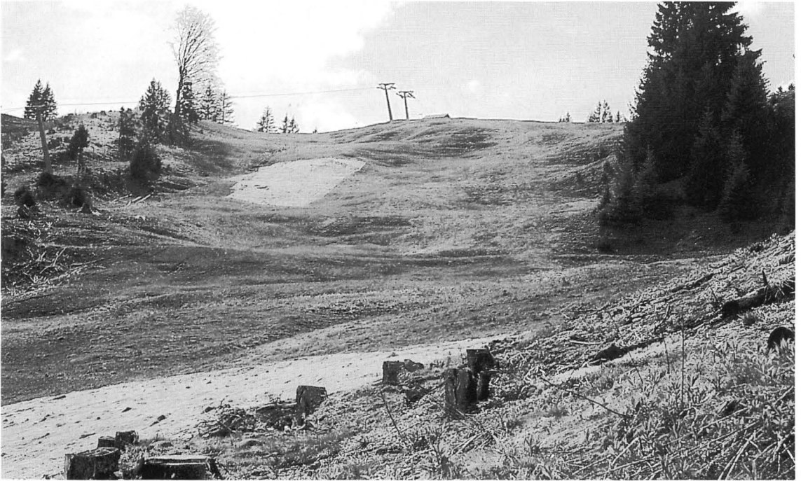
Bild 5: Durch Baumaßnahmen stark belastete Flächen im Pistenbereich bedürfen in den Folgejahren einer (kosten)intensiven Pflege: Nachbegrünung und Schutz durch Jutenetze, Auszäunung aus der Beweidung.
