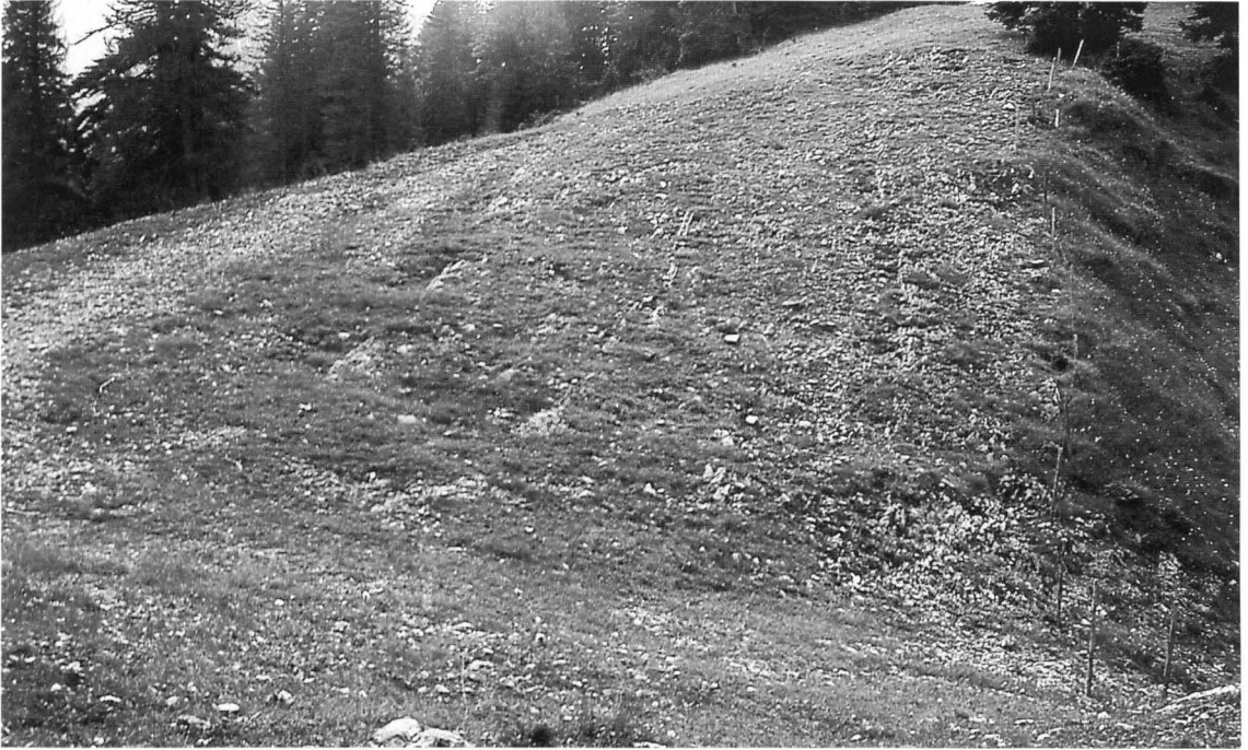
Bild 1: Planierter Pistenabschnitt mit Hanganschnitt.
