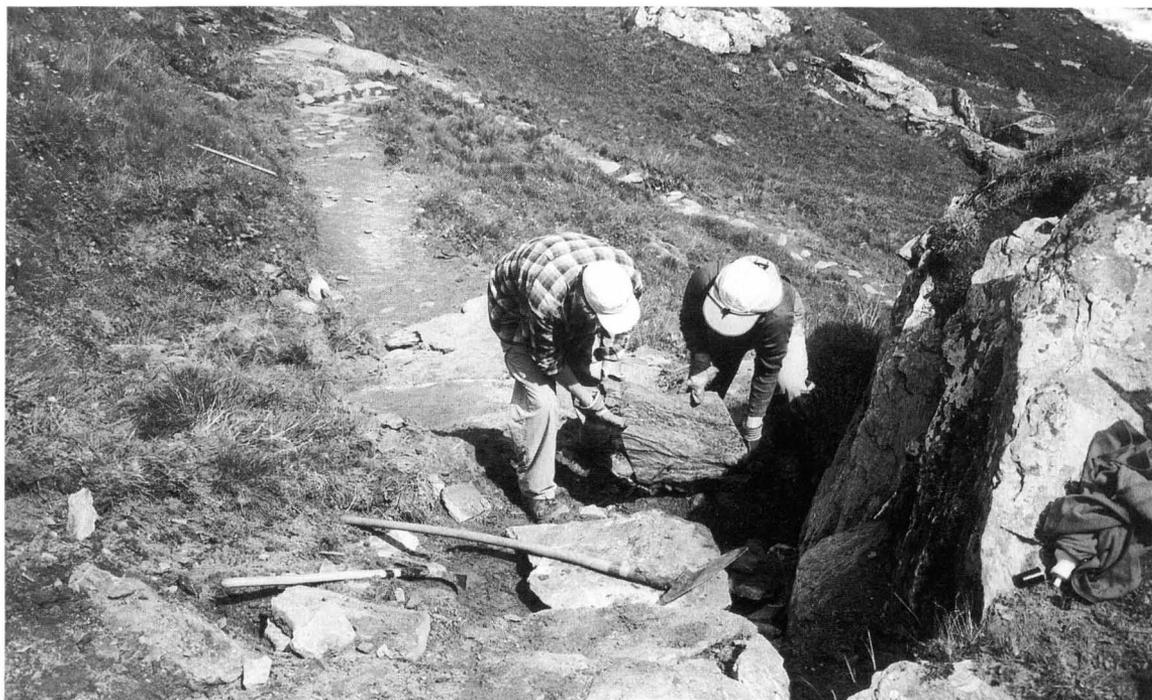
Abb. 32: Einbau von Stufen von Hand.
