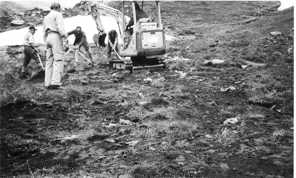
Abb. 18: Einebnung des Bereiches auf ca. 2280 m, einsetzen der vorhandenen Rasensoden als Initalpflanzung zwischen angesäten Bereichen.
