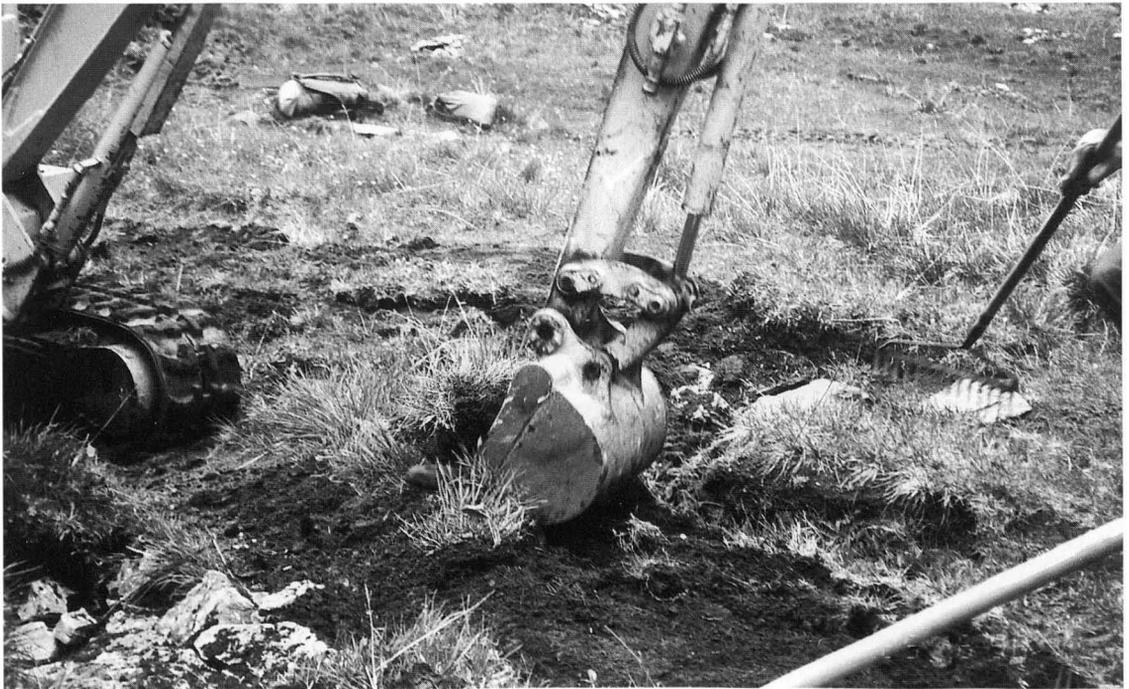
Abb. 16: Maschineller Wiederauftrag von abgehobenen Rasensoden.
