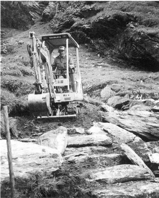
Abb. 33: Einbau von Stufen mit Bagger.
