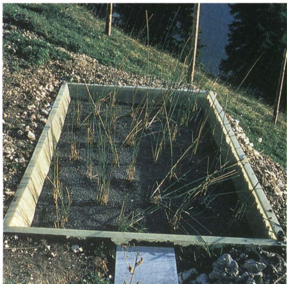
Bild 7: Pilotprojekt zur Reinigung der Abwässer der Tannheimer Hütte (1760 m) / Allgäuer Alpen durch eine Pflanzenkläranlage Foto: Franz Speer
