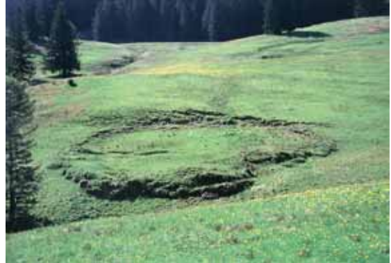
Bild 8: Erosionsschaden auf baulich veränderten Pistenabschnitten
