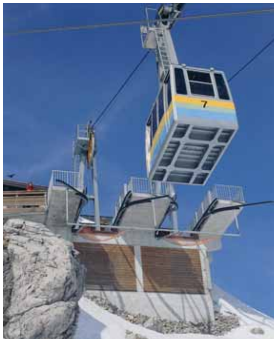
Bild 2: Kabinenbahn mit Bergstation
