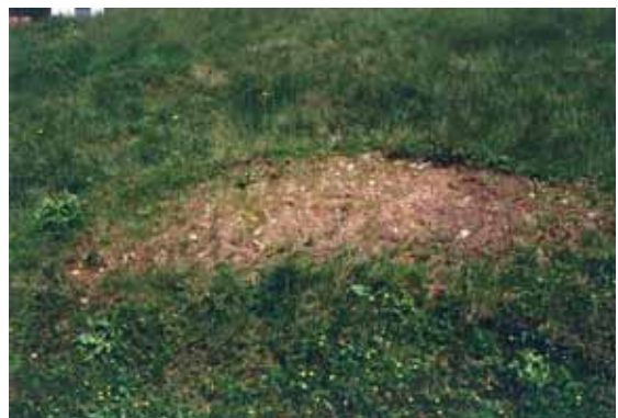
Bild 12: Kantenrasur: typischer Schaden an der Grasnarbe
