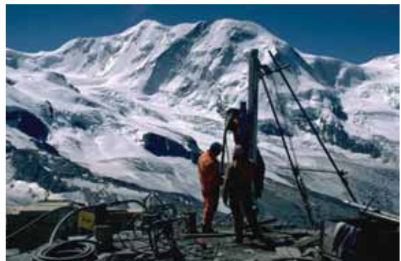
Abb. 6: Bohrung eines 100 m tiefen Bohrlochs nahe dem Stockhorn (CH, 3400 m ü. M.) oberhalb von Zermatt. Die Bohrung wurde 2000 im Rahmen des EU-Projekts PACE erstellt und seither werden darin kontinuierlich die Temperaturen des Untergrunds gemessen. Im Hintergrund sind der Grenzgletscher und der Lyskamm sichtbar. Foto W. Haeberli.
