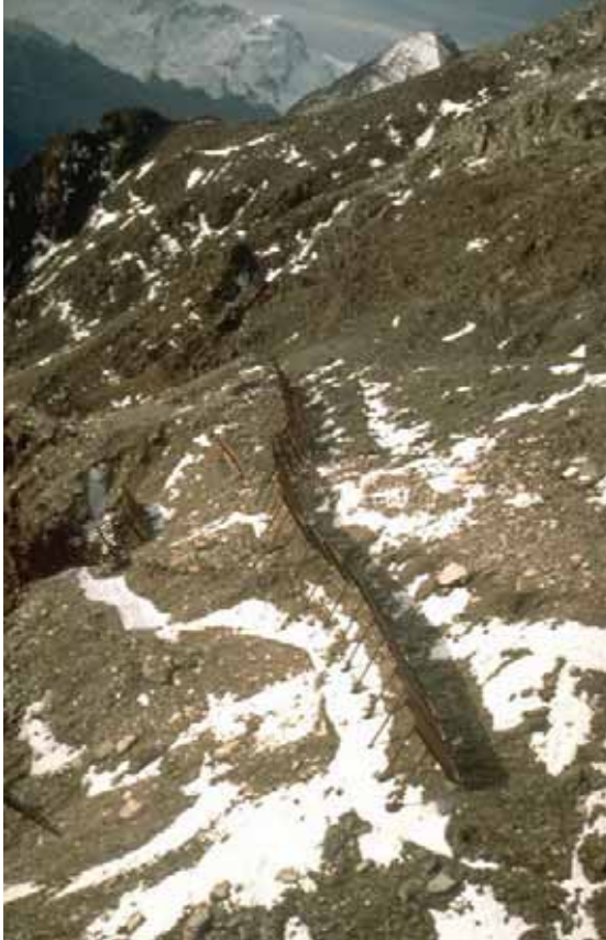
Abb. 8: Lawinenverbauungen bei Wisse Schijen oberhalb von Randa im Mättertal (CH). Die Deformation der Strukturen durch die Kriechbewegungen des Hanges sind deutlich sichtbar: ca. 1,5 m in 5 Jahren. Die Verbauungen wurden unterdessen entfernt und an anderer Stelle neu aufgestellt. Foto: Stefan Margreth (SLF).
